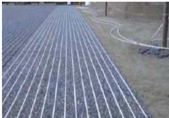
Kunstrasenkollektoren: In Dämpfungsschicht des Kunstrasenfelds integriertes Bohrungssystem zur Wärmege- winnung. Quelle: Planungsbüro Wegmüller, Klosters.
