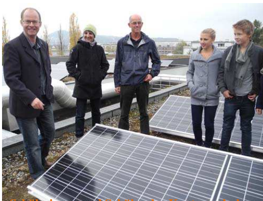
Schülerinnen und Schüler der Kantonsschule Alpenquai Luzern installieren das letzte Solarpanel der neuen Photovoltaik-Anlage
