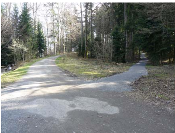
Abbildung: Verzweigung Spazierweg und Güterstrasse bei Rastplatz oberhalb Wolfsschlucht
