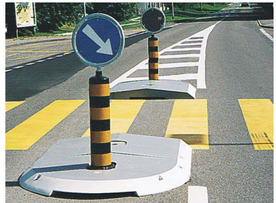
Abbildung: Prinzip der Verkehrsinsel aus Recycling-Kunststoff, allerdings Elemente mit einem Abstand von 15 m, kein Fussgängerstreifen und ohne Signal "Hindernis umfahren".
