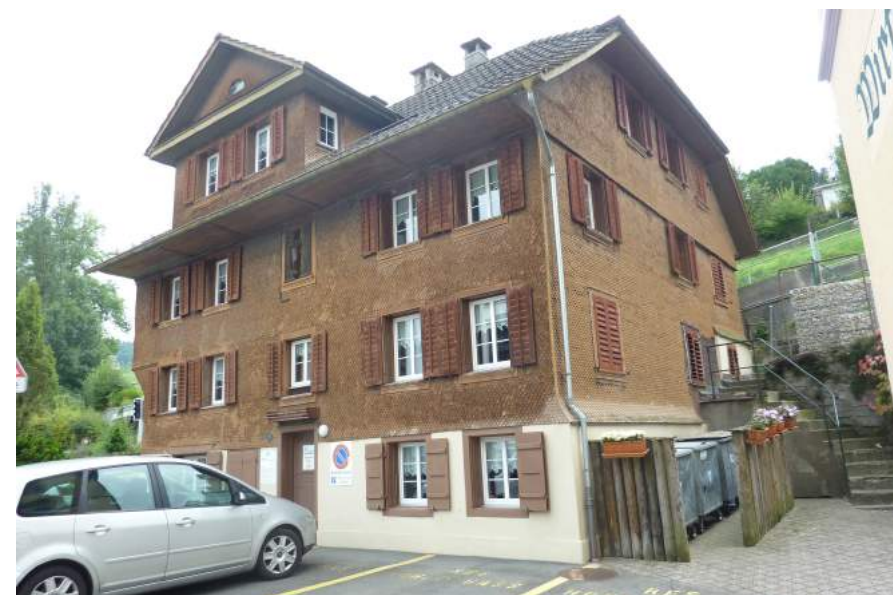
Hohle Gasse 4, Ansicht von NO
