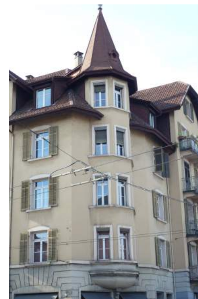
Luzernerstrasse 73, Erkerturm, Ansicht von O
