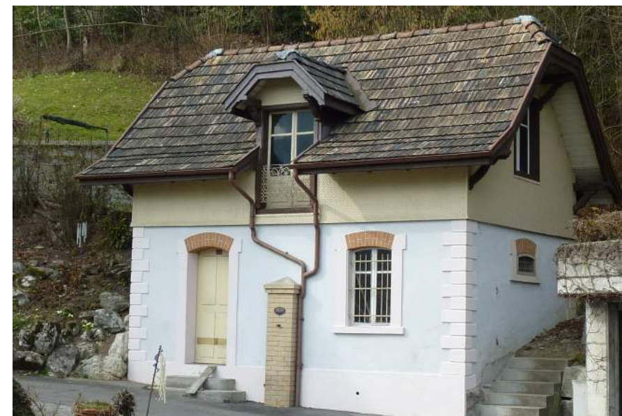
Weinhalde, Waschhaus, Ansicht von S
