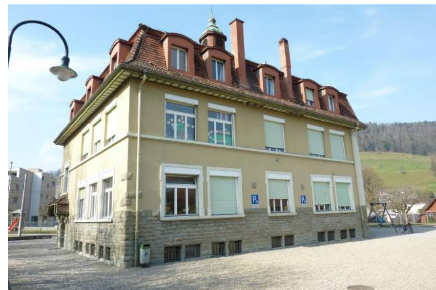
Hergiswaldstrasse 23, Schulhaus Obernau, Ansicht von SO
