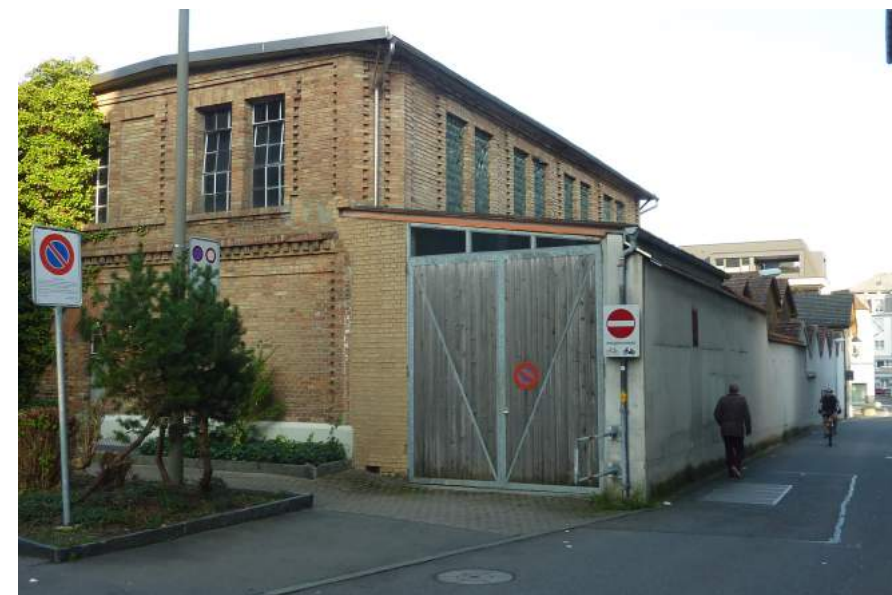
Obernauerstrasse, Kesselhaus, Ansicht von SW
