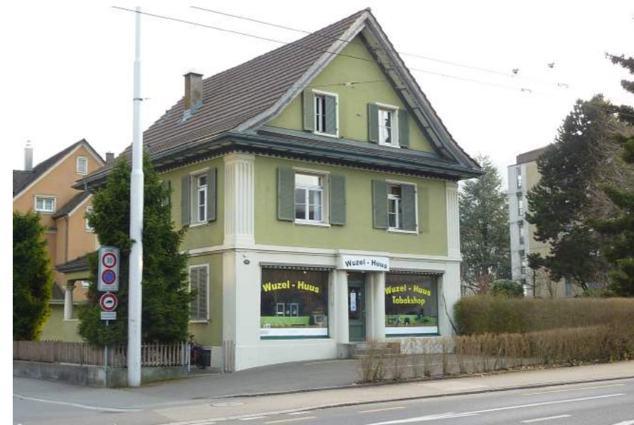
Luzernerstrasse 66, Ansicht von NO
