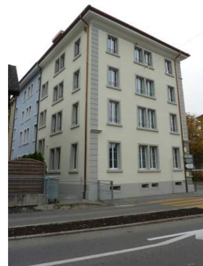
Horwerstrasse 8, Ansicht von S
