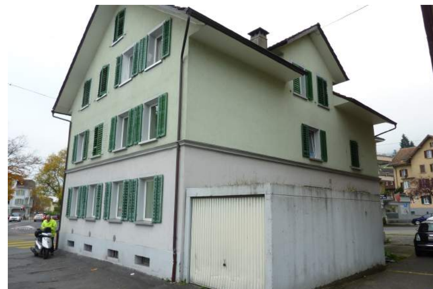
Gallusstrasse 7, Neubreithaus, Ansicht von N
