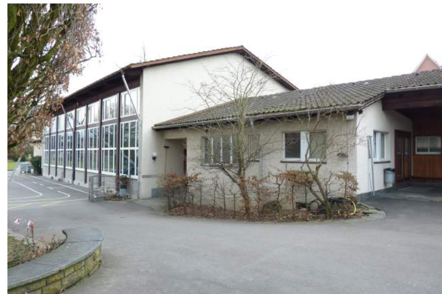
Brunnmattstrasse, Schulhaus Brunnmatt, Turnhalle und Pausenhalle, Ansicht von NO
