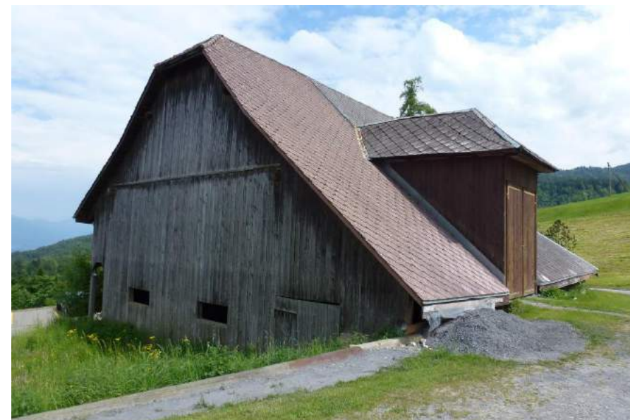
Hergiswald, Scheune, Ansicht von NW
