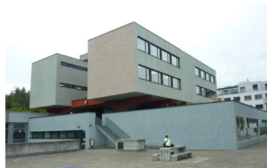
Krauerstrasse, Krauerschulhaus, Ansicht von SO (Aufnahme 2014)
