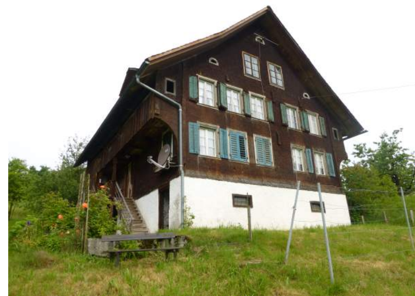
Schattenbergstrasse, Höllhof, Ansicht von SO
