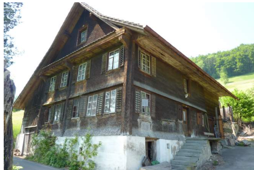
Ehrendergerstrasse, Vorder-Sienen, Ansicht von SO
