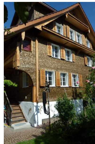
Horwerstrasse 130, Ansicht von S
