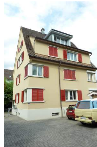
Horwerstrasse 59, Ansicht von SW
