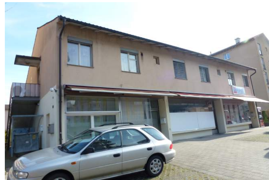
Luzernerstrasse 90, Ansicht von NW
