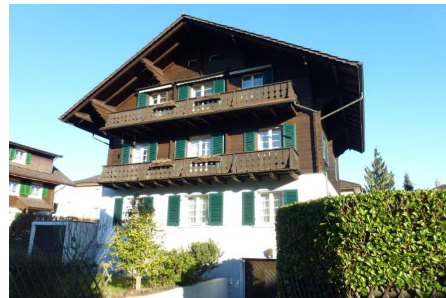
Pilatusstrasse 21, Ansicht von SW
