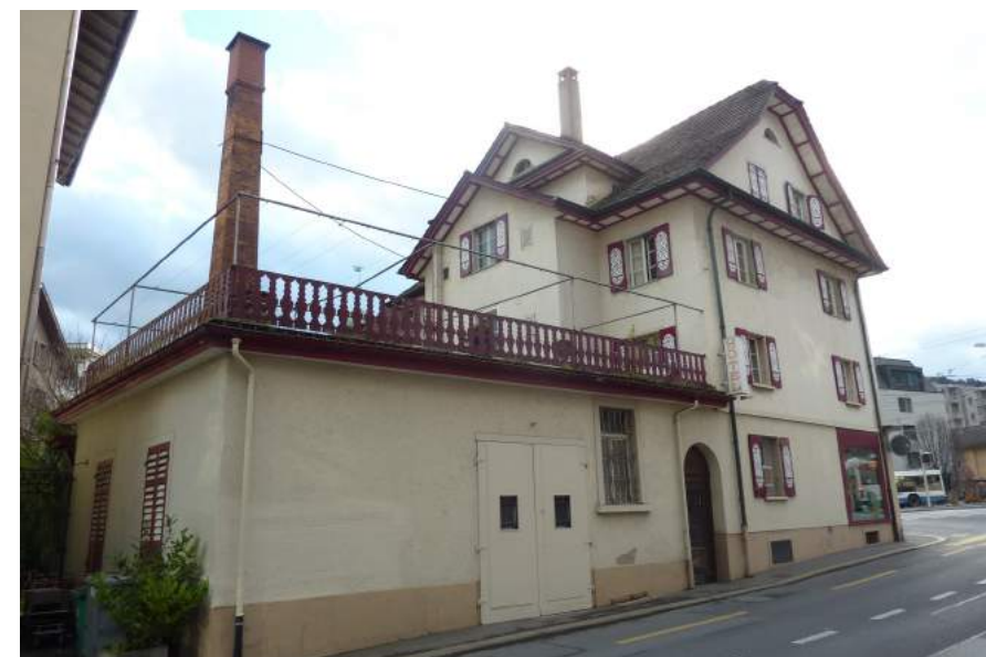
Obnauerstrasse 2, Neubäckerei, Ansicht von NO
