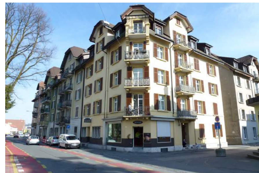
Kupferhammer, Amlehnstrasse, Ansicht von W
