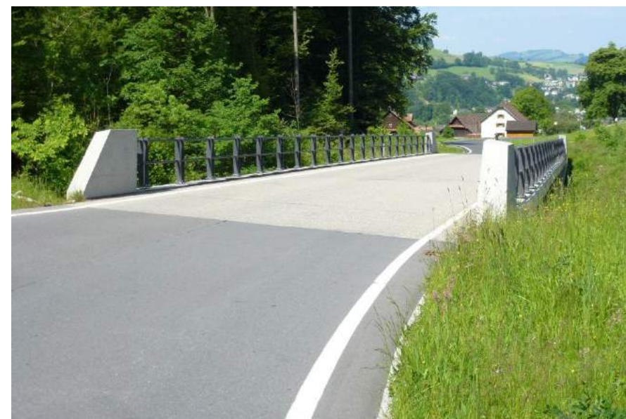
Hergiswaldstrasse, neue Hergiswaldbrücke, Ansicht von SW
