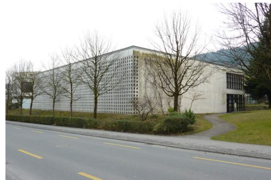
Hackenrainstrasse 2, Ansicht von NW
