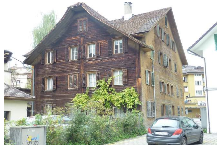
Gallusstrasse 5, Altbreithaus, Ansicht von S
