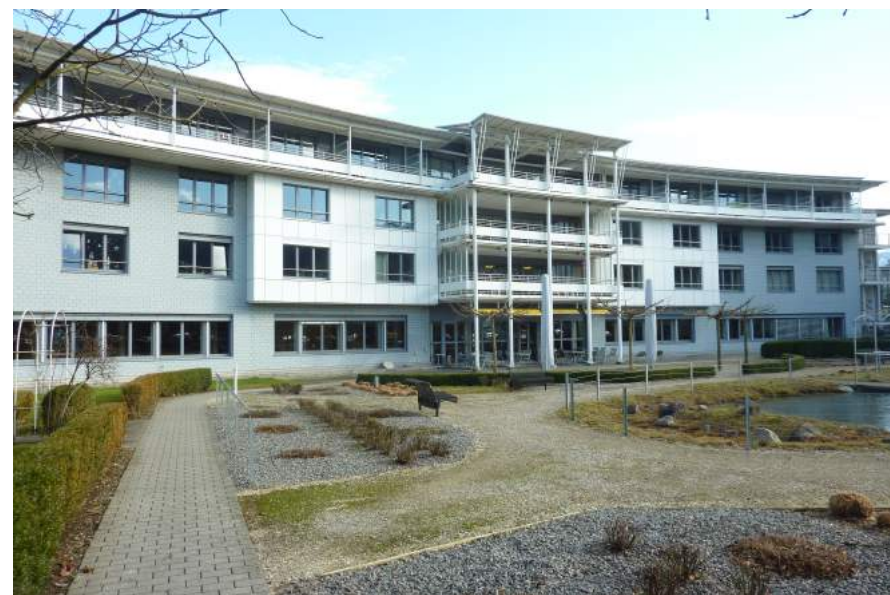
Horwerstrasse 33, Alters- und Pflegeheim Zunacher, Ansicht von W
