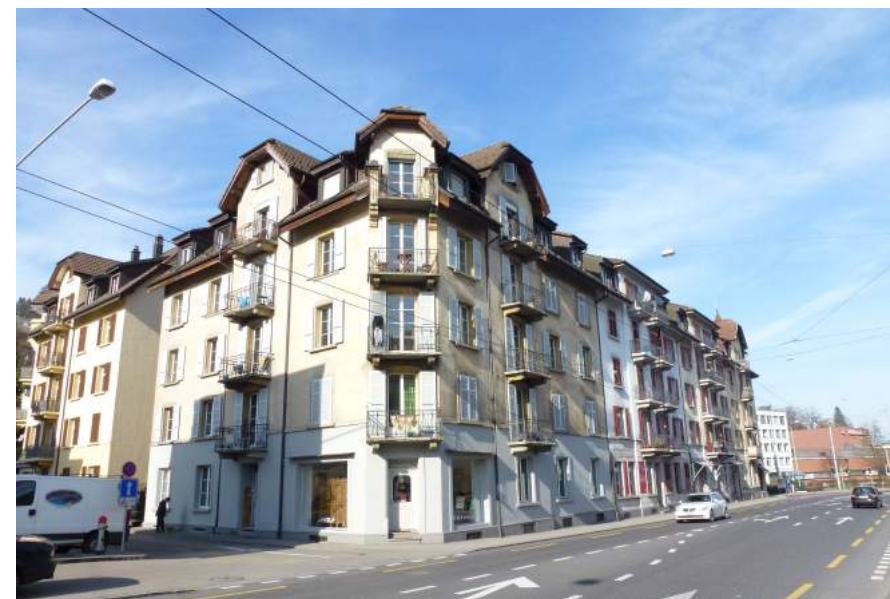
Luzernerstrasse 69, Ansicht von S
