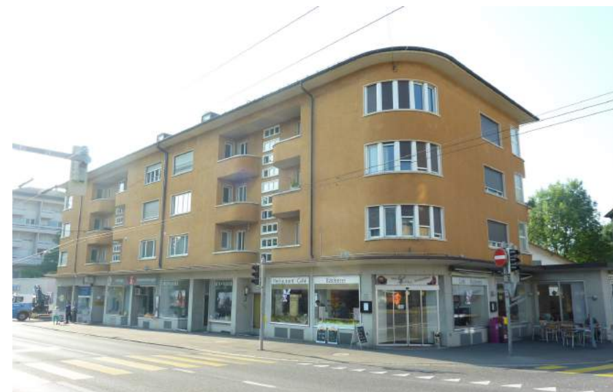
Luzernerstrasse 24, Ansicht von NW
