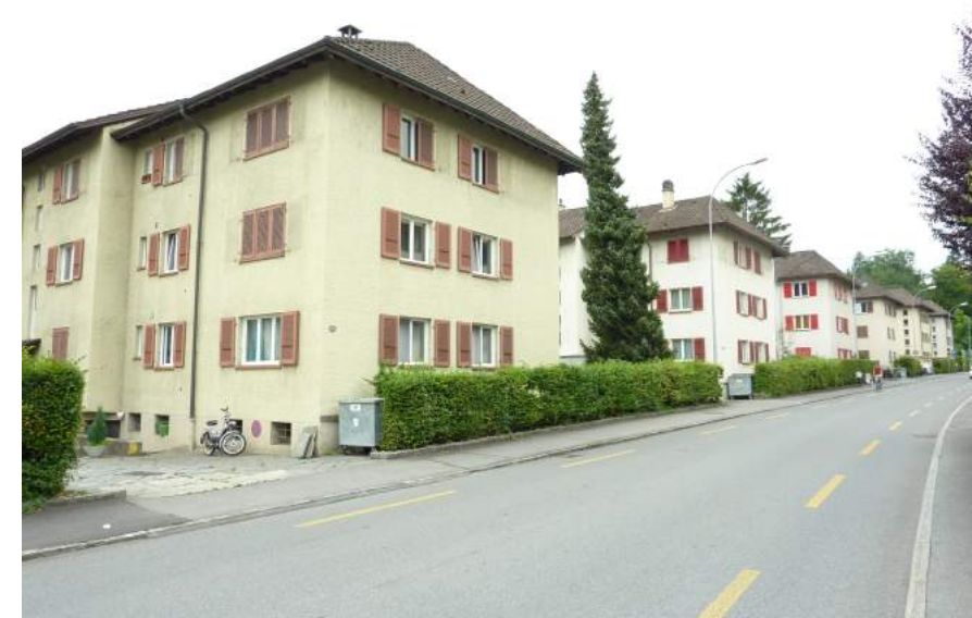
Schachenstrasse, Ansicht von NO
