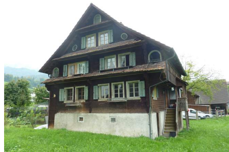
Obermatt, Ansicht von NO
