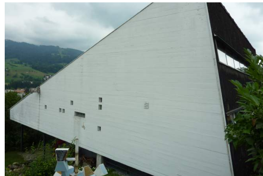
Bergstrasse 28, Ansicht von NO
