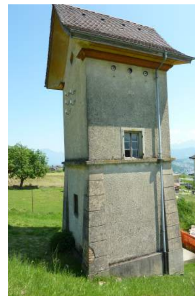
Gabeldingen, Transformatorenhaus, Ansicht von NW
