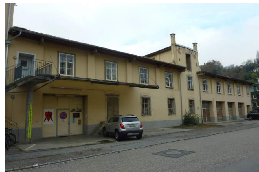
Degenstrasse, Teiggi Langbau, Ansicht von SO
