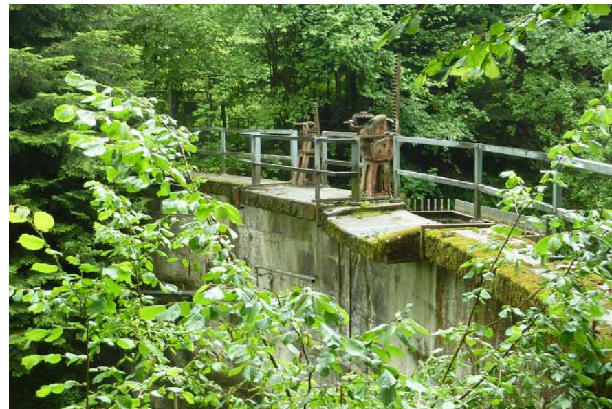
Hinter-Katzenbalg, Staumauer Bellenweiher, Ansicht von W
