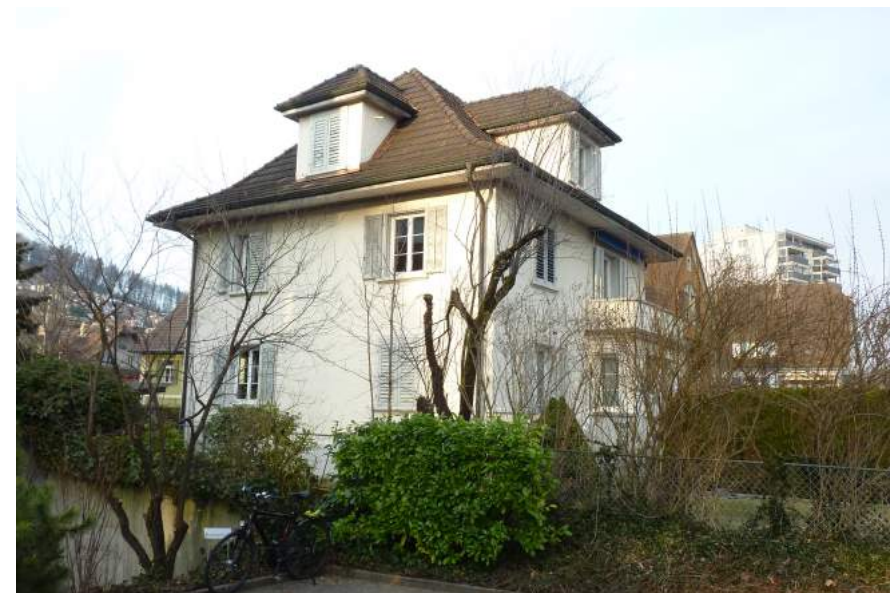
Hochrainstrasse 13, Ansicht von SW
