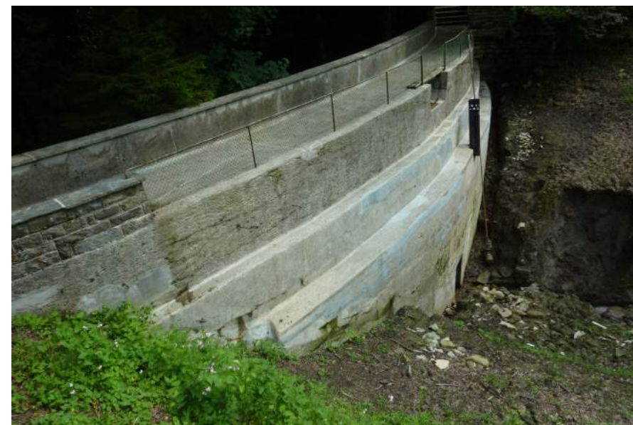
Bruderhusen, Staumauer, Ansicht von N
