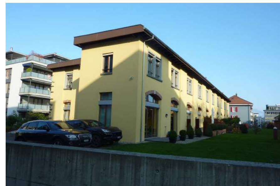
Pulvermühleweg 12, ehem. Hauptgebäude Lachappelle, Ansicht von SW
