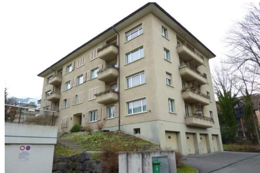
Spitzmattstrasse 7, Ansicht von NO
