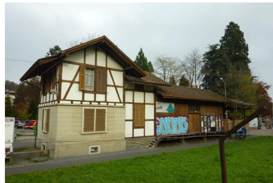
Güterstrasse, KLB-Bahnhof, Ansicht von SW (Aufnahme 2014)
