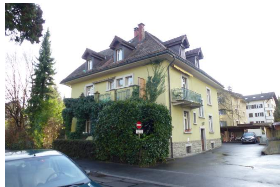
Luzernerstrasse 49, Villa Komet, Ansicht von NO
