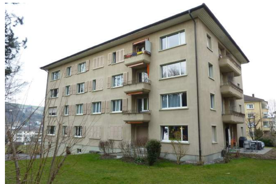
Spitzmattstrasse 7, Ansicht von SW
