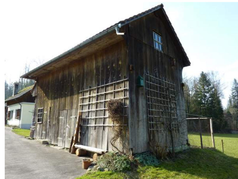
Längacher, Trotte, Ansicht von SO
