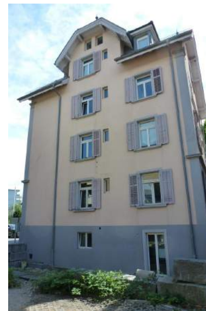
Luzernerstrasse 47, Ansicht von NW
