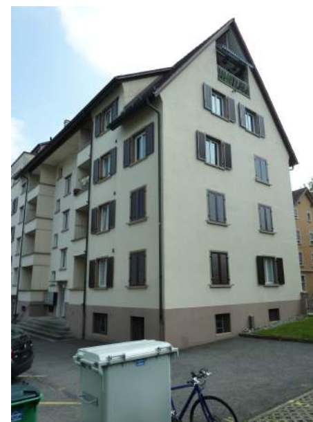
Luzernerstrasse 37, Ansicht von NW
