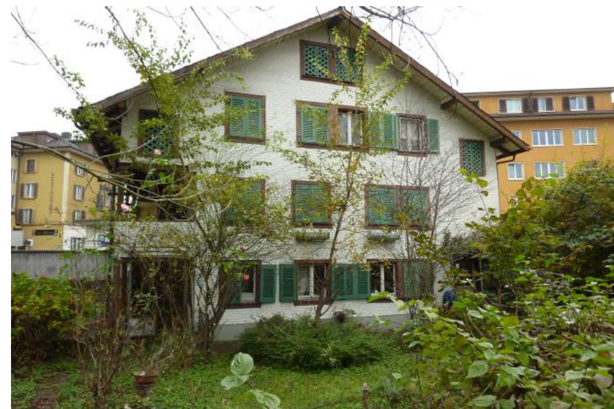
Horwerstrasse 1a, Ansicht von S
