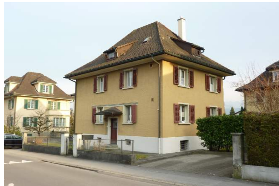
Hochrainstrasse 14, Ansicht von NW
