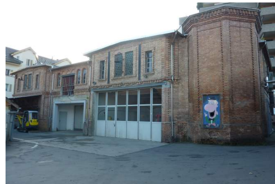
Obernauerstrasse, Kesselhaus, Ansicht von NO
