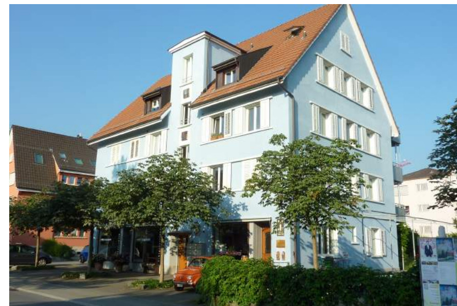
Alpenstrasse 32, Ansicht von NO
