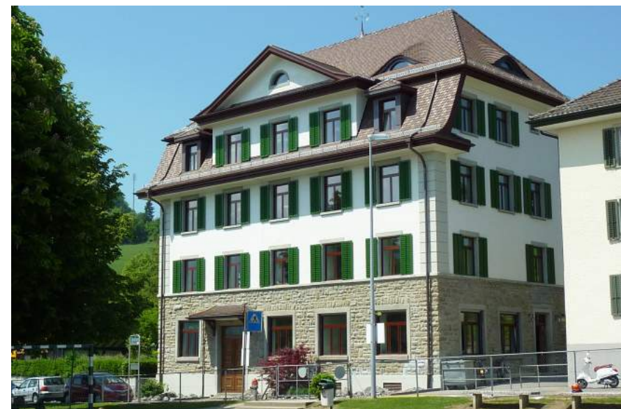
Gabeldingenstrasse, Schulhaus Gabeldingen, Ansicht von SO
