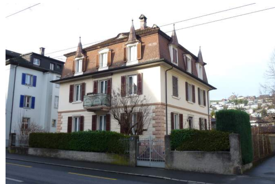
Luzernerstrasse 25, Frohalp I, Ansicht von SO
