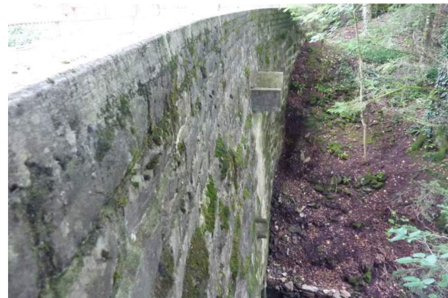
Bruderhusen, Staumauer, Ansicht von S
