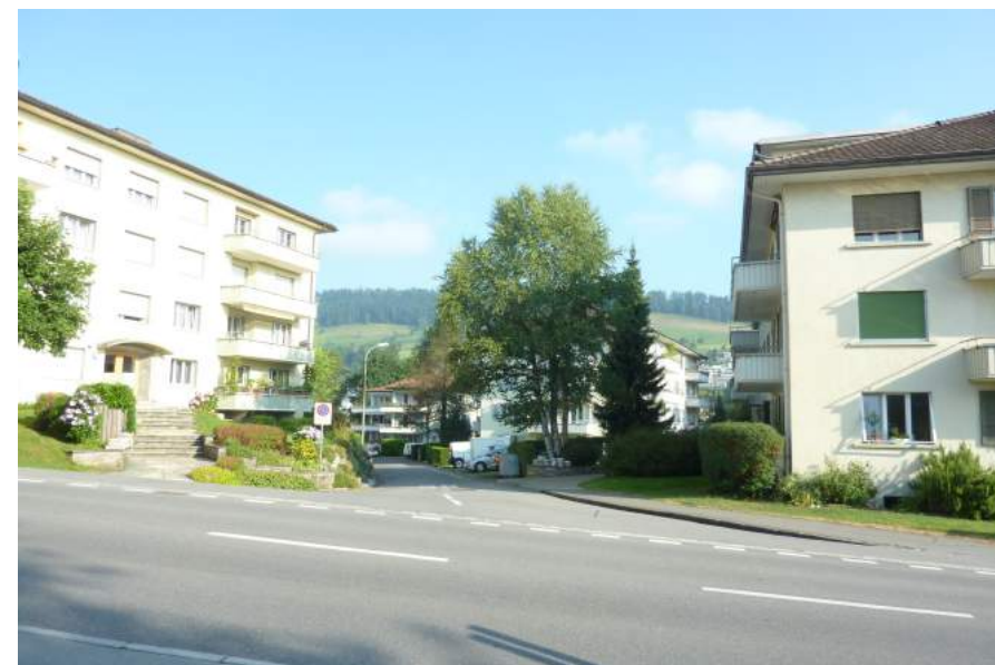
Miba-Häuser, Ansicht von SO
