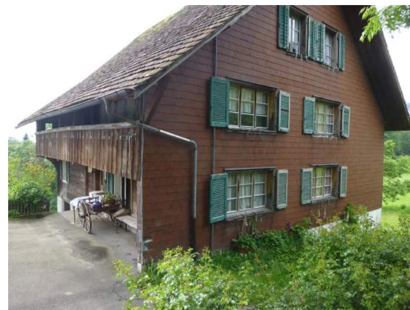
Schattenbergstrasse, Höllhof, Ansicht von NW
