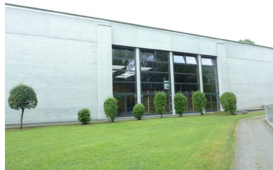
Südstrasse, Schulhaus Meiersmatt, Turnhalle, Ansicht von NO
