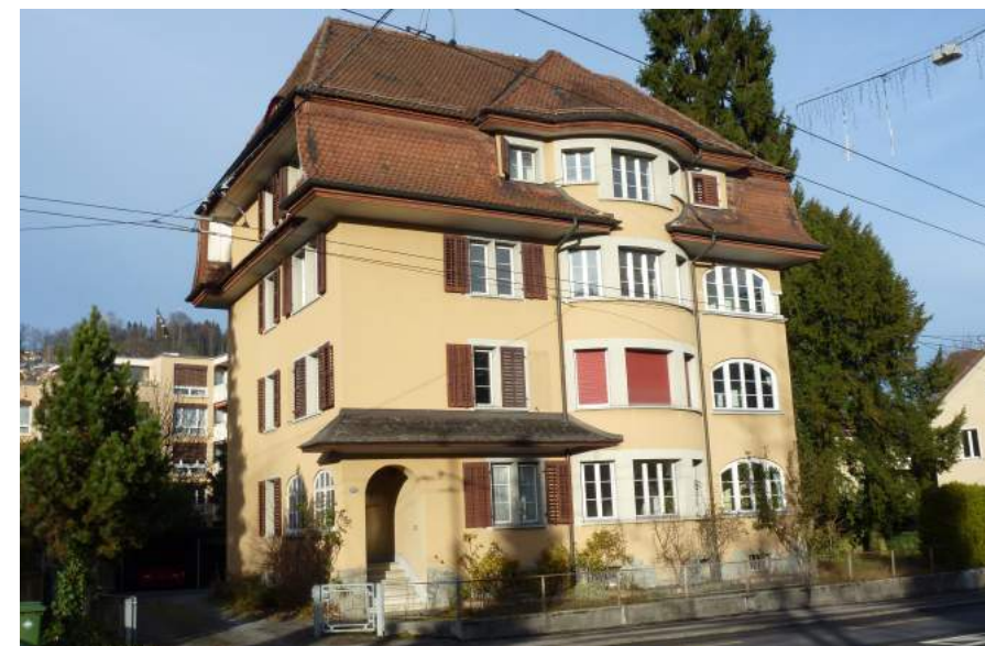
Luzernerstrasse 43, Ansicht von S
