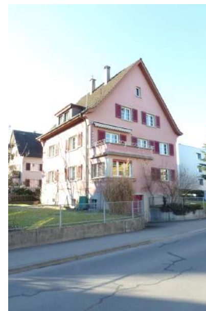
Brünigstrasse 1, Ansicht von SO
