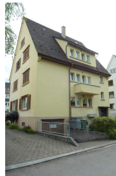
Furkastrasse, Ansicht von NO
