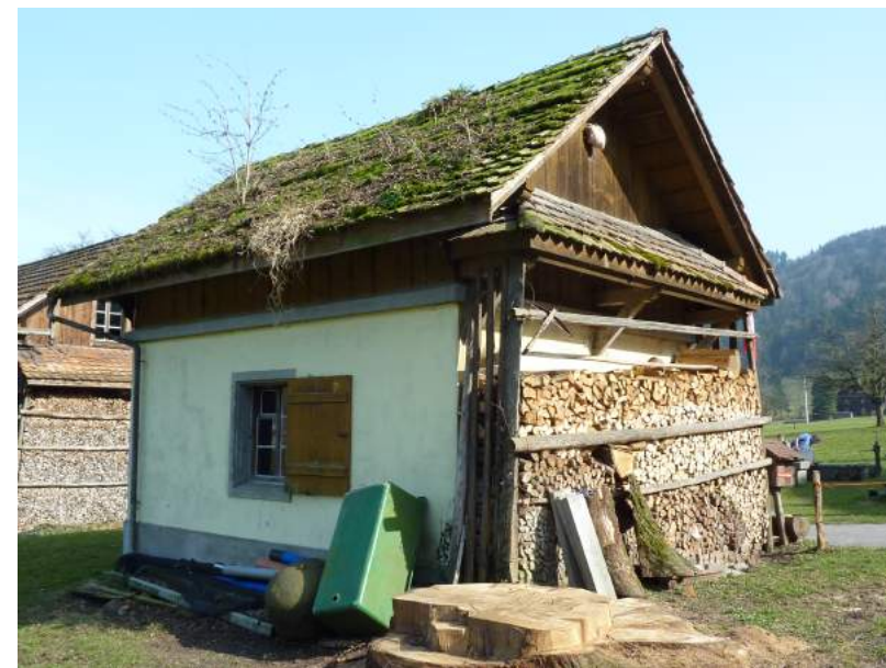
Längacher, Waschhaus, Ansicht von NW
