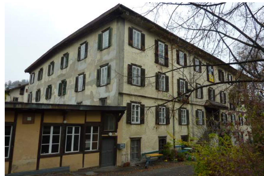
Luzernerstrasse 33 c, Alte Ziegelei, Ansicht von SW
