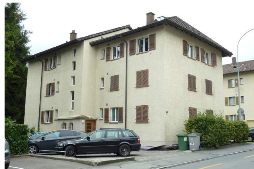
Schachenstrasse 30, Ansicht von NO
