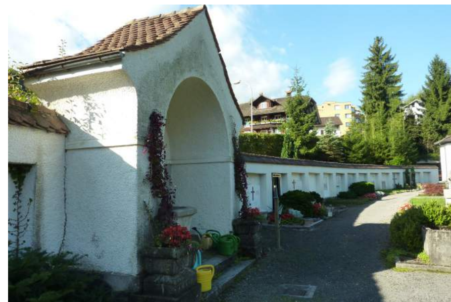
Friedhofstrasse 2, Friedhosmauer innen, Ansicht von NO
