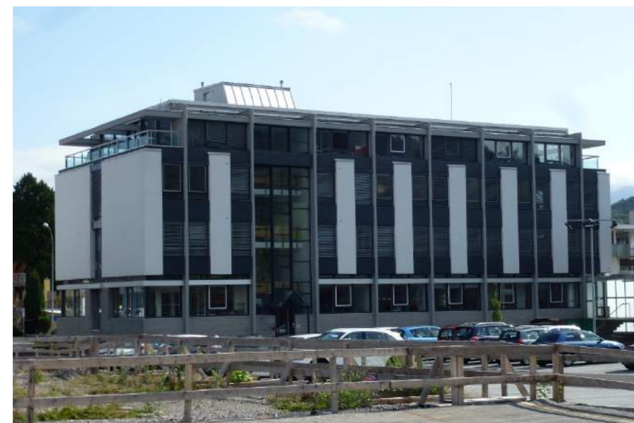
Horwerstrasse, Verwaltungsgebäude, Ansicht von W
