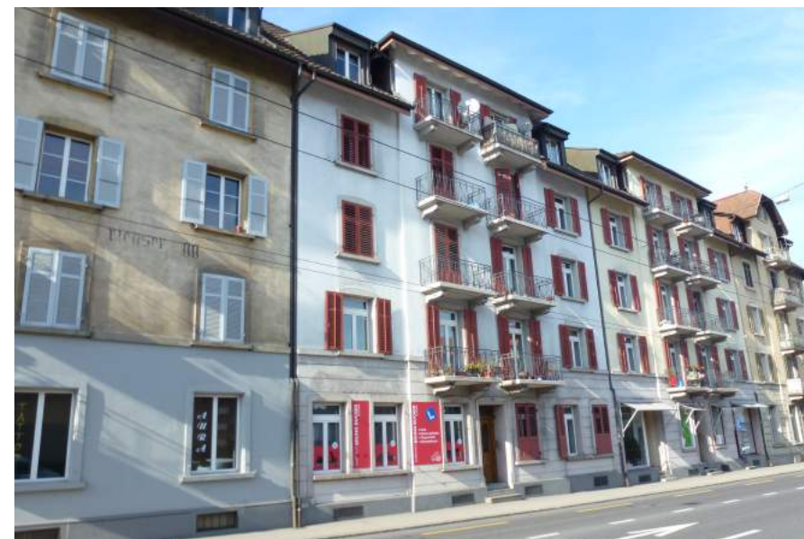
Luzernerstrasse 69, Ansicht von S
