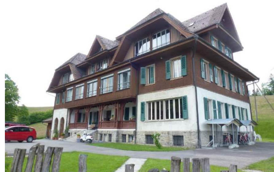
Schürhofstrasse, Lehnhof, Ansicht von O
