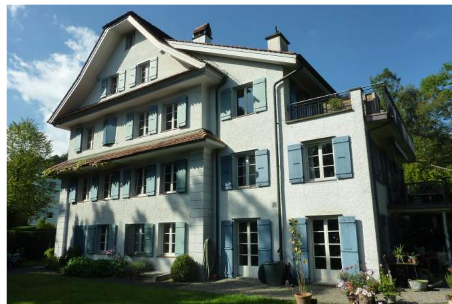
Schlundstrasse 69, Lauerzhaus, Ansicht von NO
