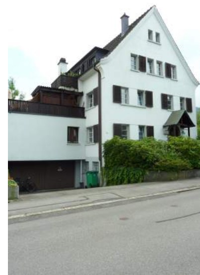
Hochrainstrasse 18, Ansicht von NO
