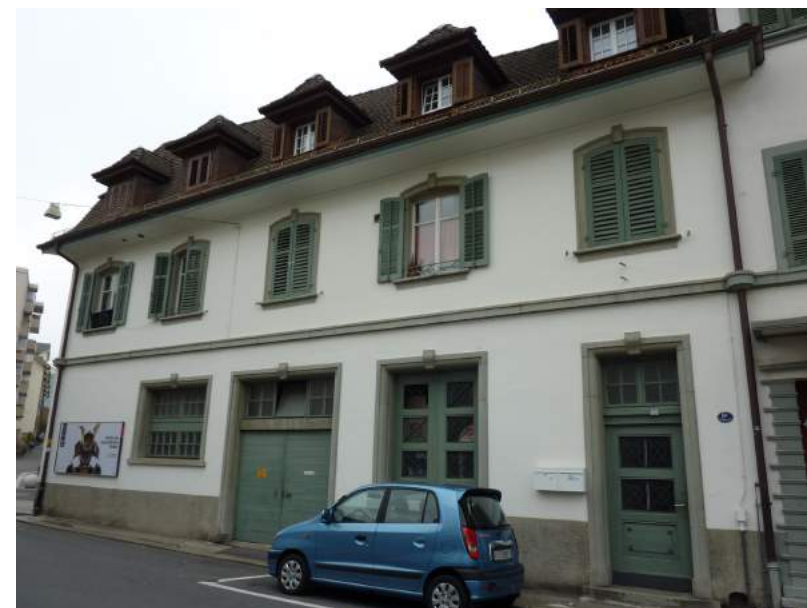
Fenkernstrasse 6a, Ansicht von SO
