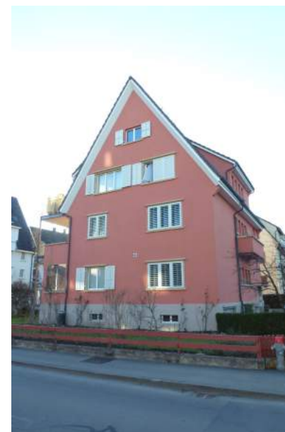
Furkastrasse 1, Ansicht von NO
