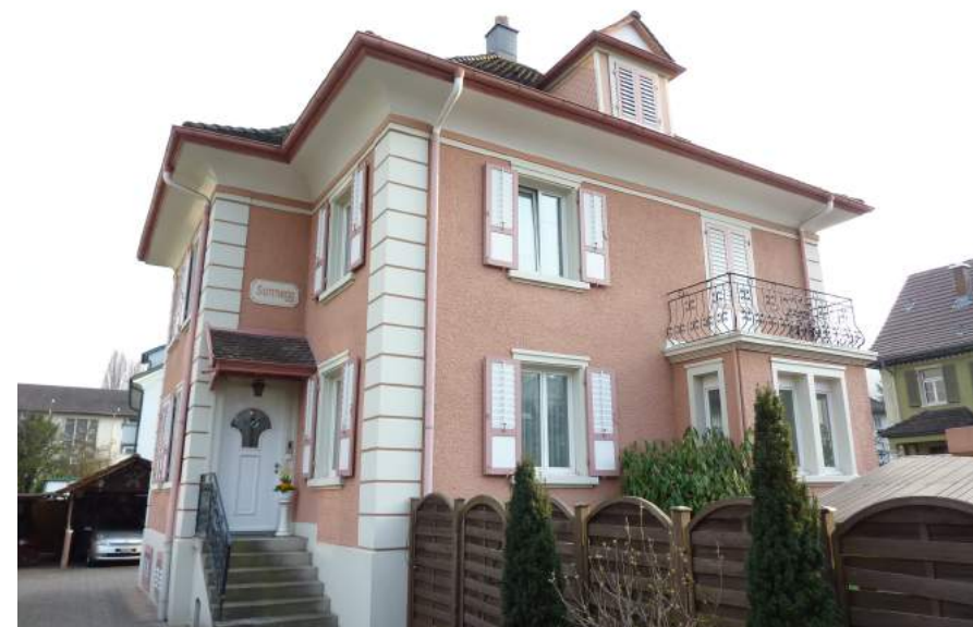
Luzernerstrasse 68, Sonnegg, Ansicht von N
