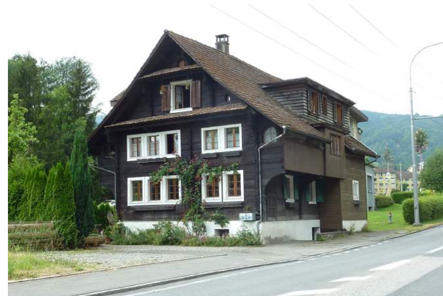
Obernauerstrasse 87, Senseschmiede, Ansicht von NO
