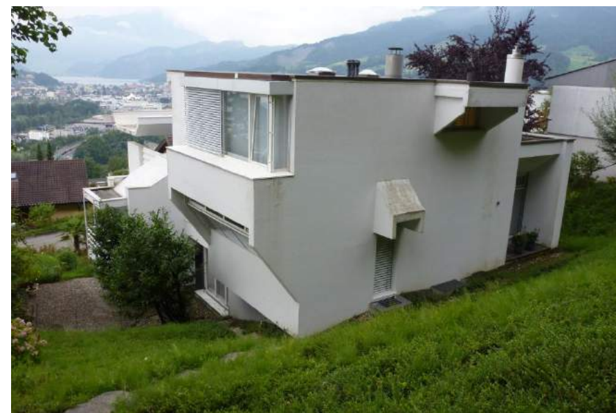
Steinhofhalde 28, Ansicht von N
