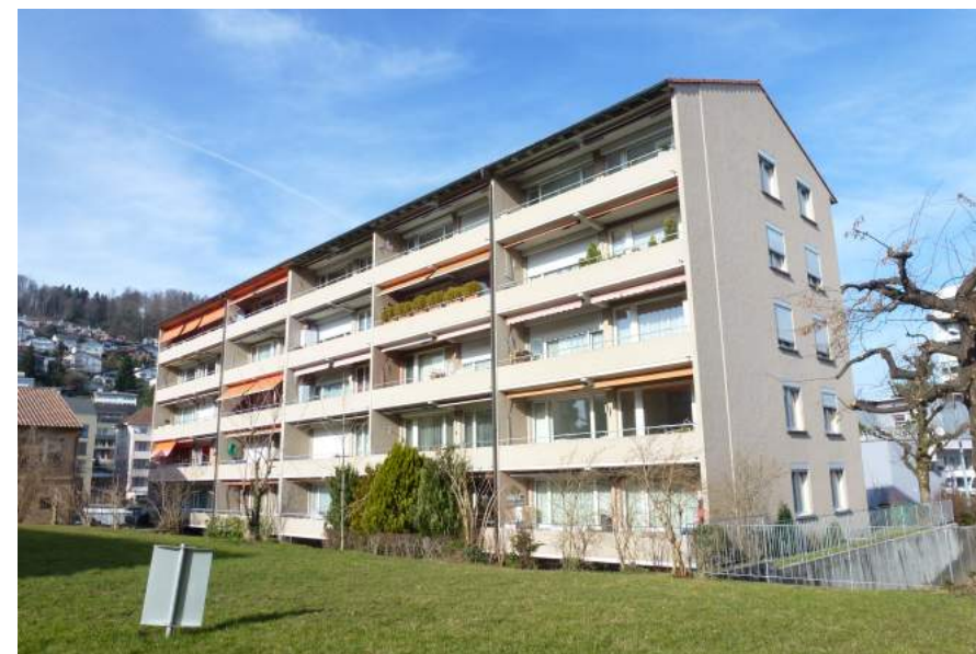
Luzernerstrasse 92, Ansicht von S
