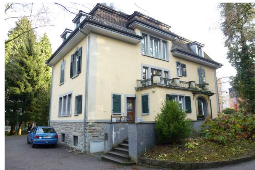
Luzernerstrasse 21, Villa Florida, Ansicht von NW
