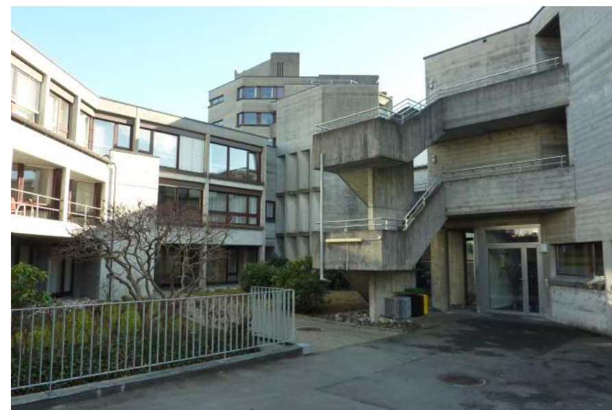
Grossfeldstrasse 6, Alters- und Pflegeheim Grossfeld, Ansicht von N
