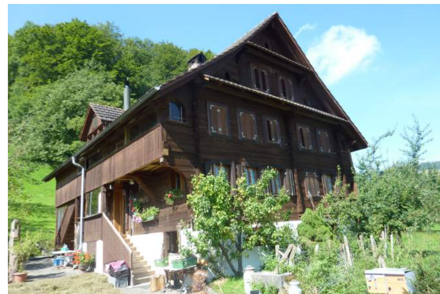
Himmelrichstrasse 16, Obermettlen, Ansicht von O
