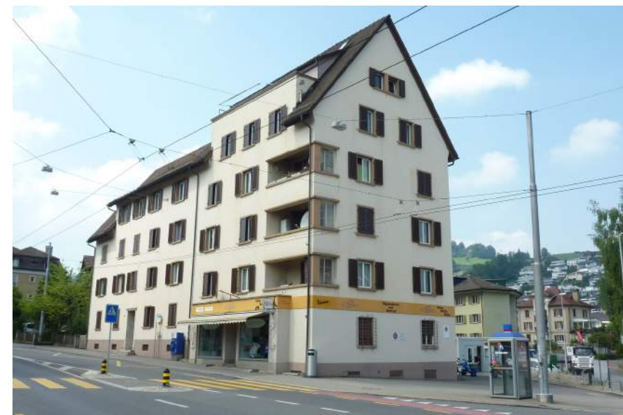
Luzernerstrasse 39, Ansicht von SO
