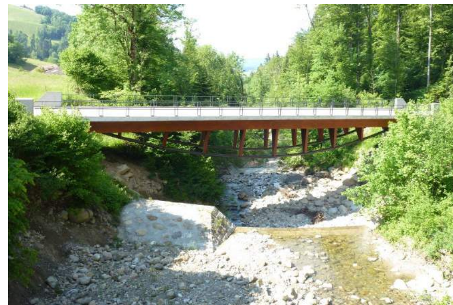
Hergiswaldstrasse, Neue Hergiswaldbrücke, Ansicht von S
