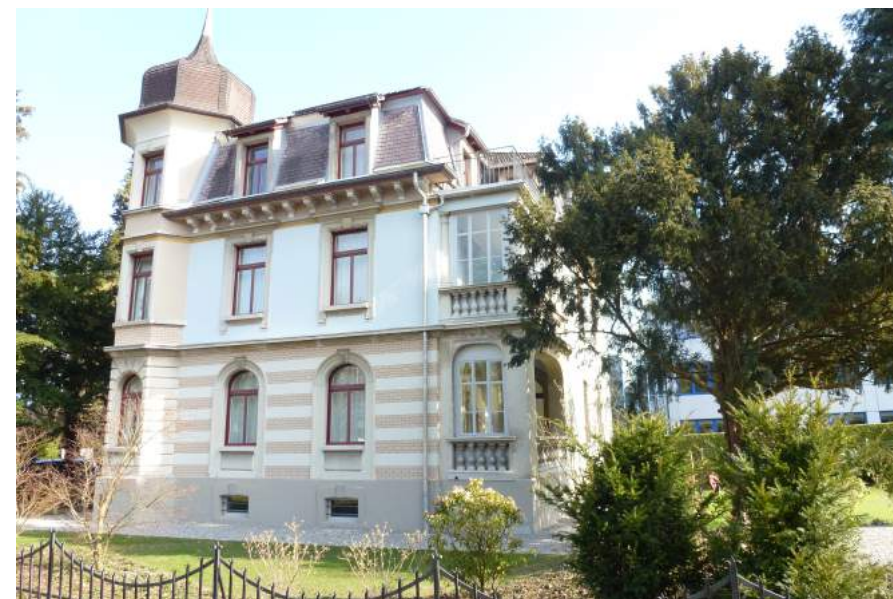
Obergrundstrasse 121, Villa Aurora, Ansicht von NW
