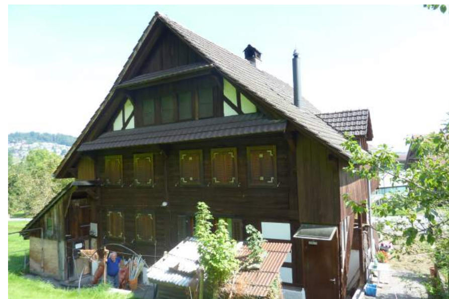
Himmelrichstrasse 16, Obermettlen, Ansicht von SW
