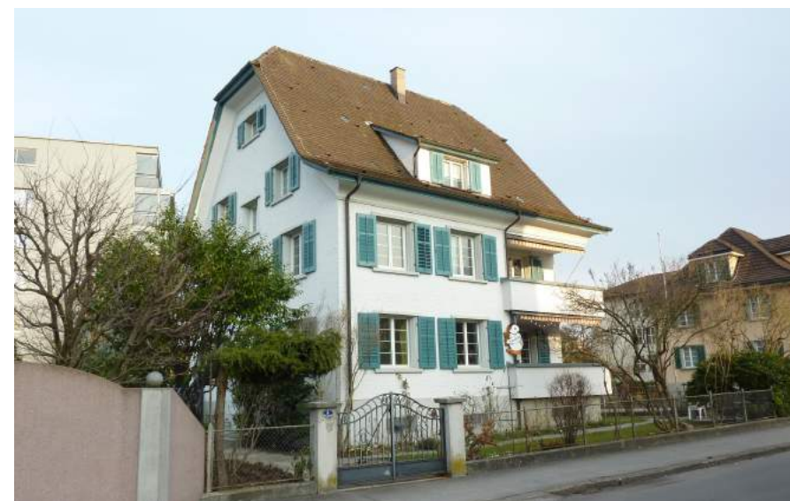
Brunnmattstrasse 3, Ansicht von NW
