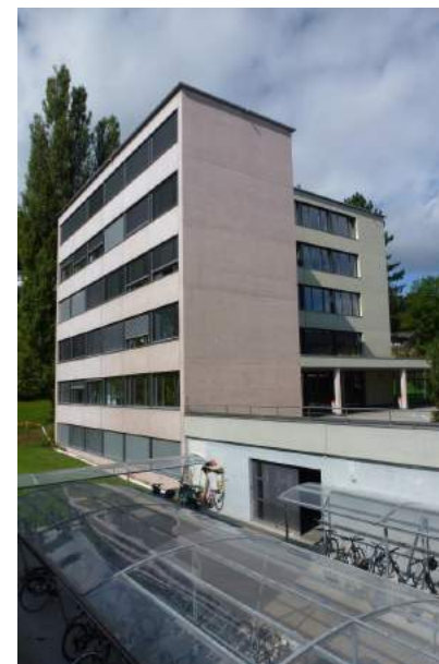
Schlundstrasse, Schulhaus Roggern 1, Ansicht von NO
