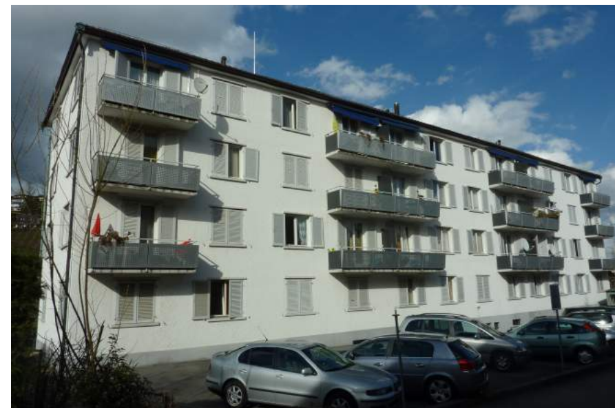
Amlehnstrasse 20, Ansicht von SW
