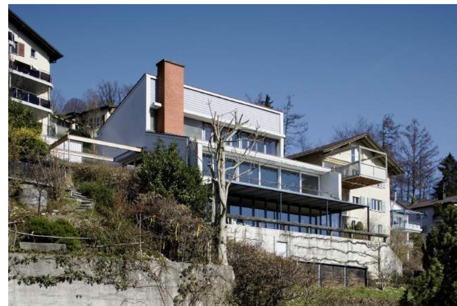
Sonnenweg 6, Ansicht von SW (Aufnahme 2007)
