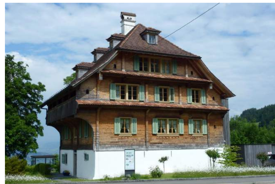
Hergiswald, Kaplanei, Ansicht von W
