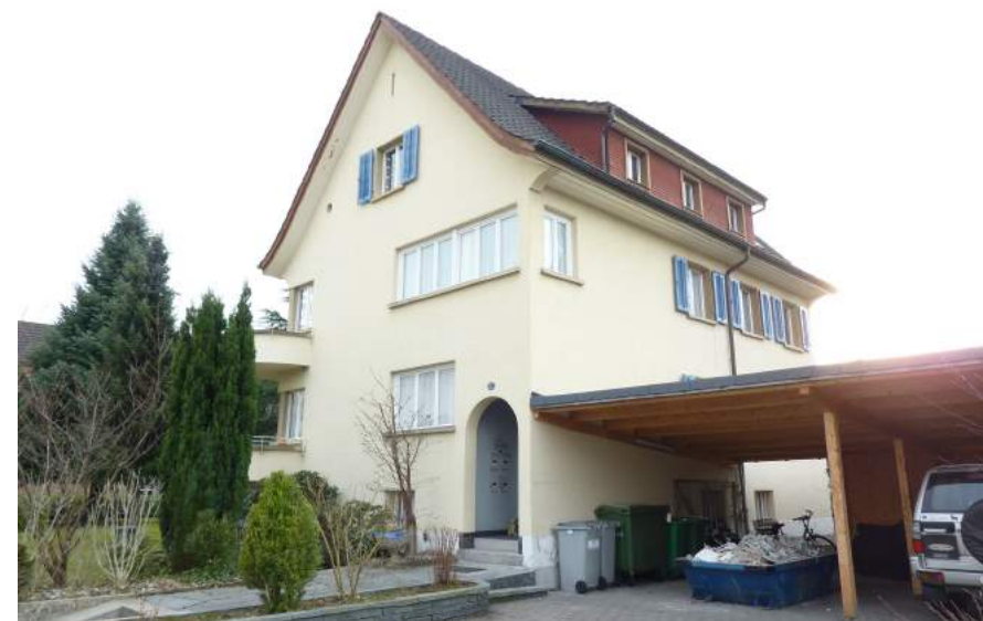
Pilatusstrasse 10, Ansicht von NO
