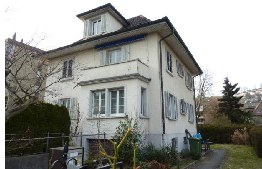
Hochrainstrasse 13, Ansicht von SO
