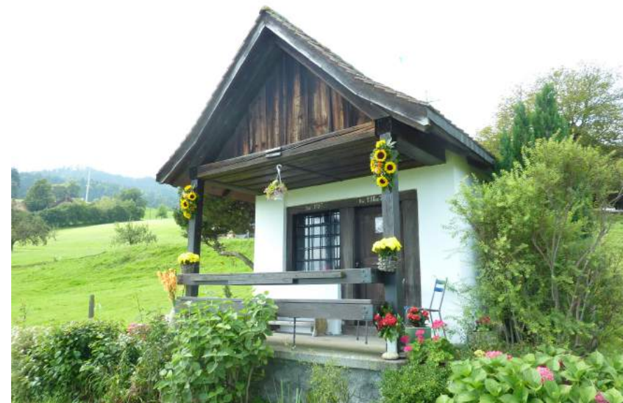
Schattenbergstrasse, Kapelle Ebersrüti, Ansicht von NO
