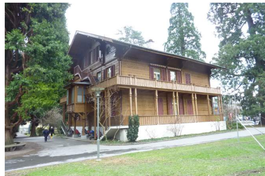
Luzernerstrasse 19, Villa Konkordia, Ansicht von NW
