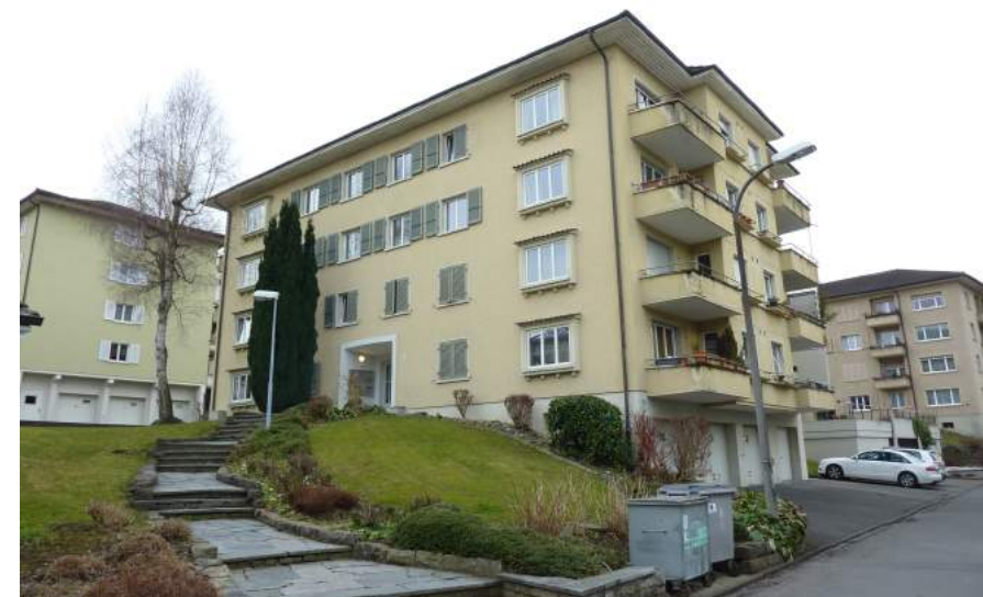
Spitzmattstrasse 5, Ansicht von NO
