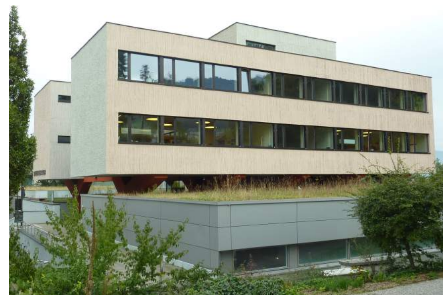
Krauerstrasse, Krauerschulhaus, Ansicht von NW (Aufnahme 2014)
