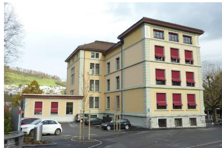
Kirchrainweg 10, Schulhaus-Kirchbühl, Ansicht von S
