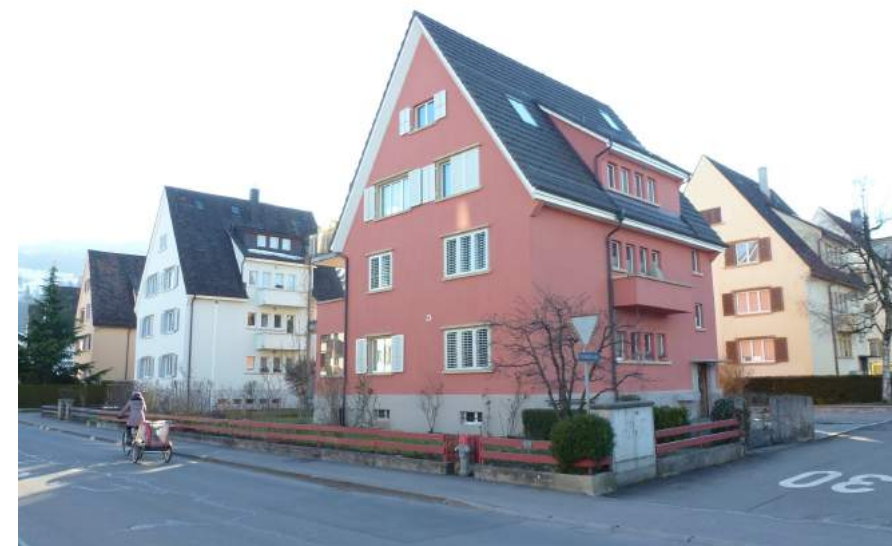
Kehrhof, Alpenstrasse/Furkastrasse, Ansicht von NO
