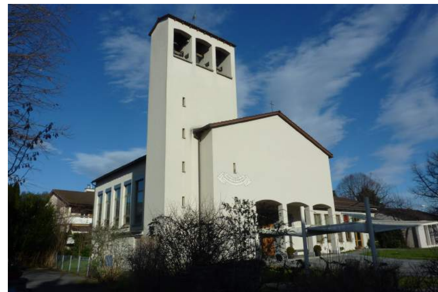
Horwerstrasse, Kirche St. Johann, Ansicht von SW
