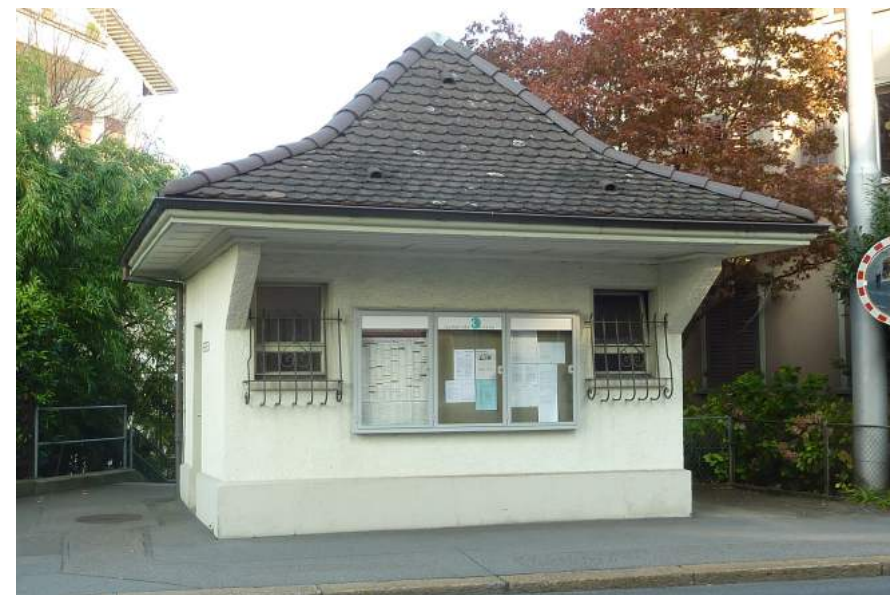
Luzernerstrasse, WC-Anlage Busschleife, Ansicht von SW
