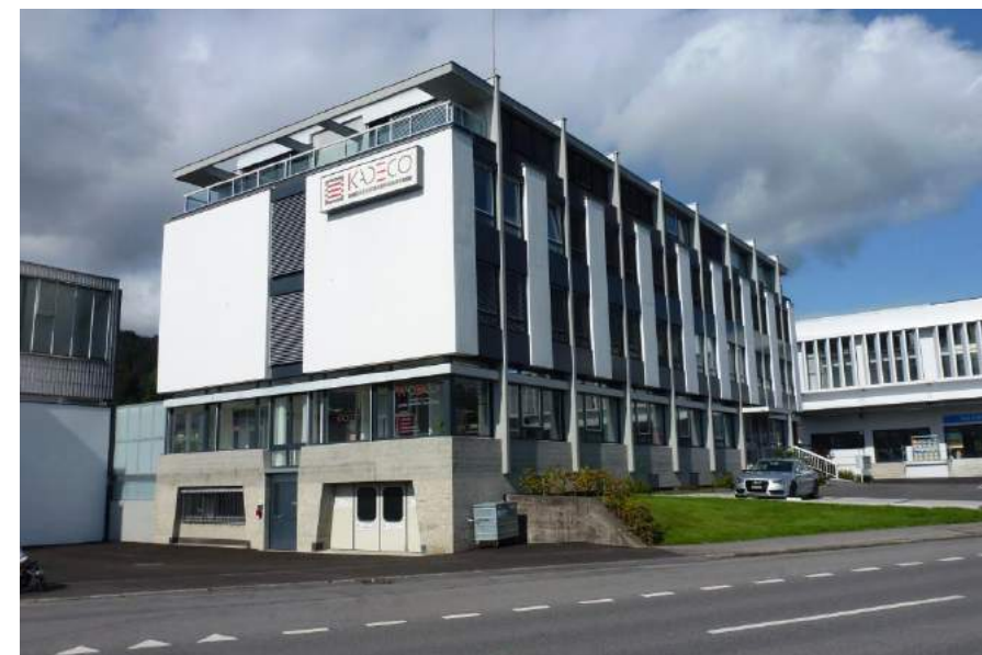
Horwerstrasse 60, Verwaltungsgebäude, Ansicht von O
