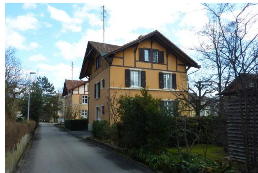
Erlenweg 3, Ansicht von W
