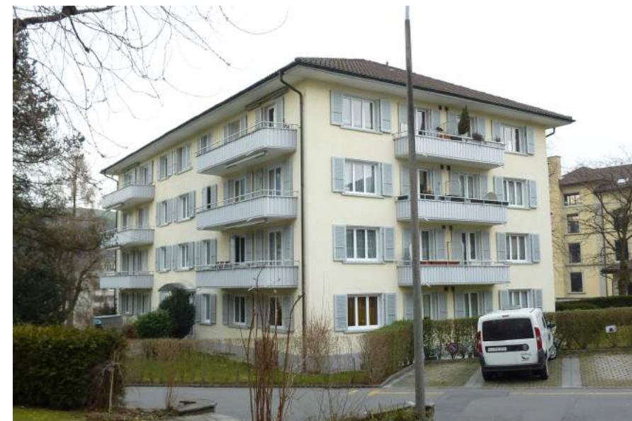
Spitzmattstrasse 4, Ansicht von SW
