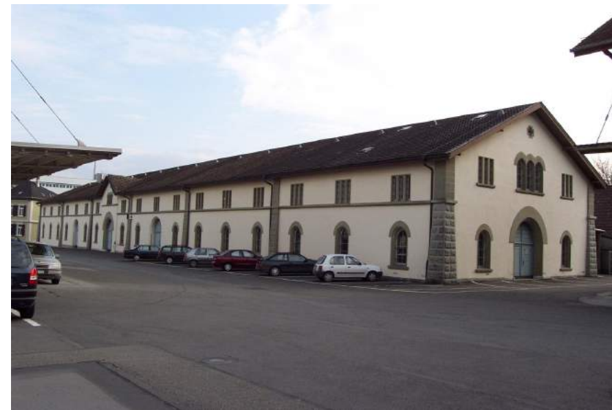
Arsenalstrasse, Zeughaus 1 / Unterkunft, Ansicht von NW
