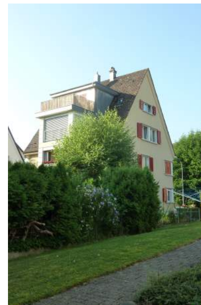
Horwerstrasse 59, Ansicht von NW
