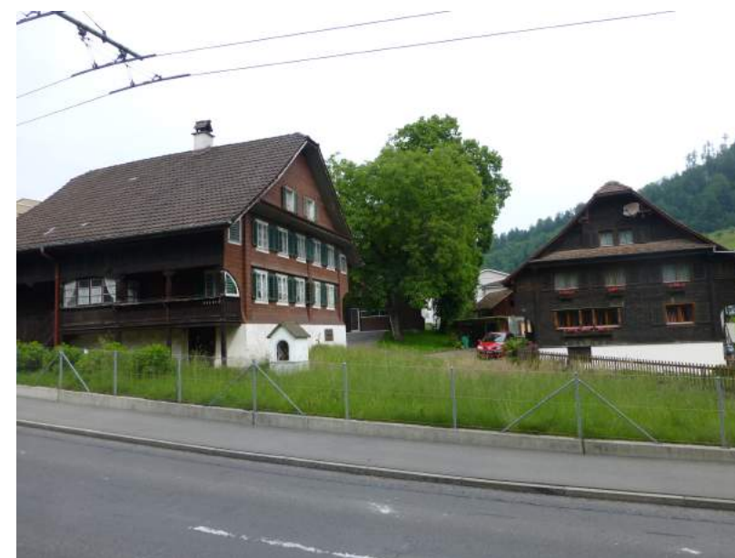
Hergiswaldstrasse 14, Ansicht von O
