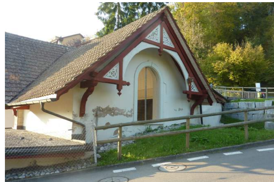
Waldheimstrasse, Talstation Sonnenbergbahn, Ansicht von O
