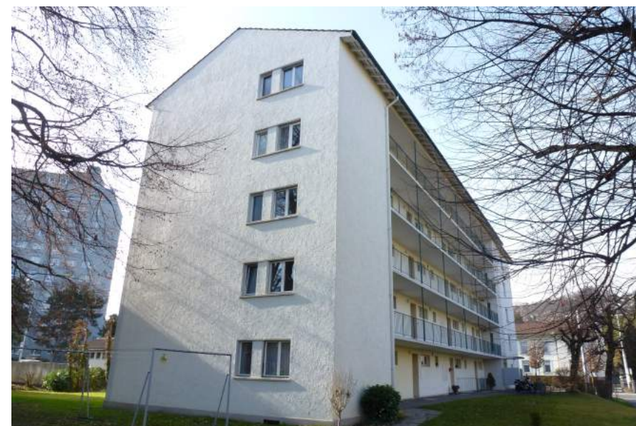
Luzernerstrasse 76, Ansicht von SO
