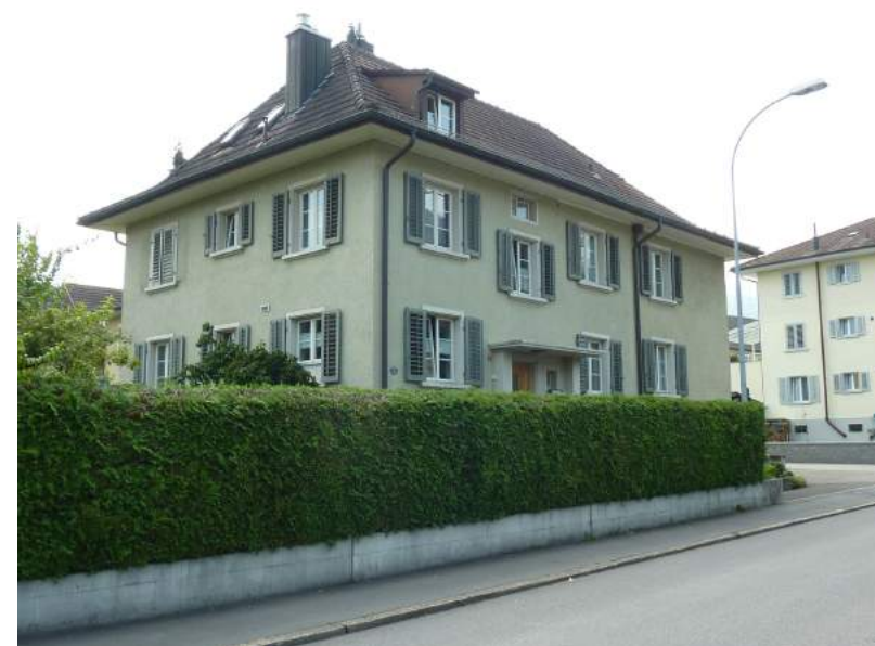
Hochrainstrasse 12, Ansicht NO
