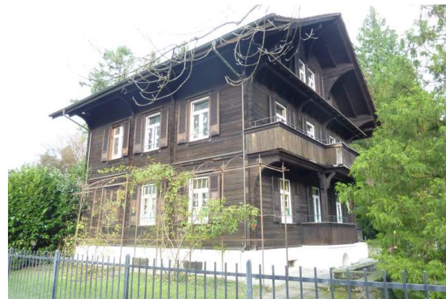
Güterstrasse 2, Villa Daheim, Ansicht von SW
