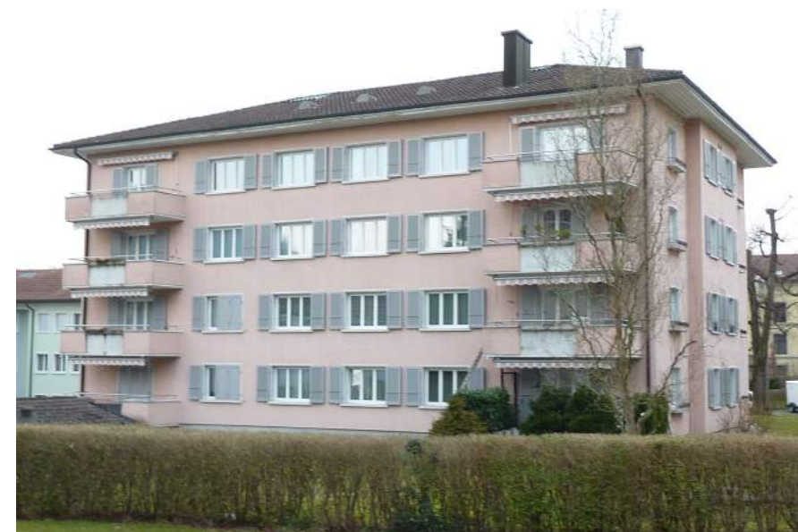
Spitzmattstrasse 3, Ansicht von SW
