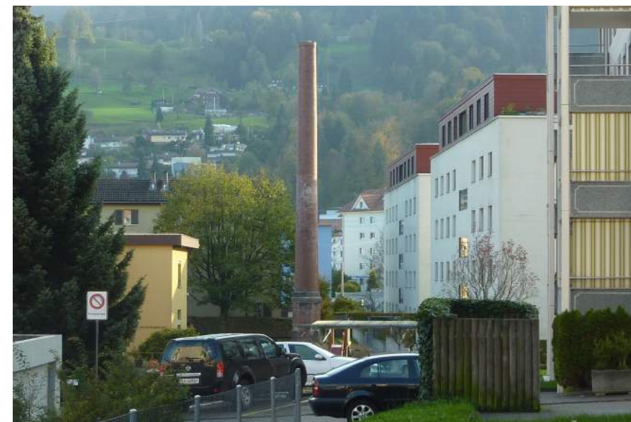
Pulvermühleweg, Hochkamin, Ansicht von N
