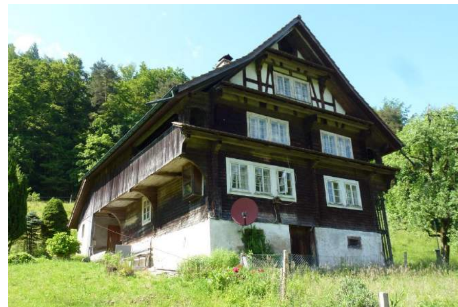
Hergiswaldstrasse, Stalden, Ansicht von S
