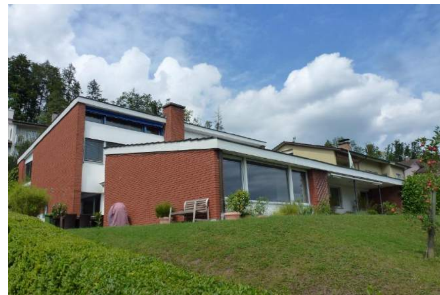
Steinhofhalde 17, Ansicht von S
