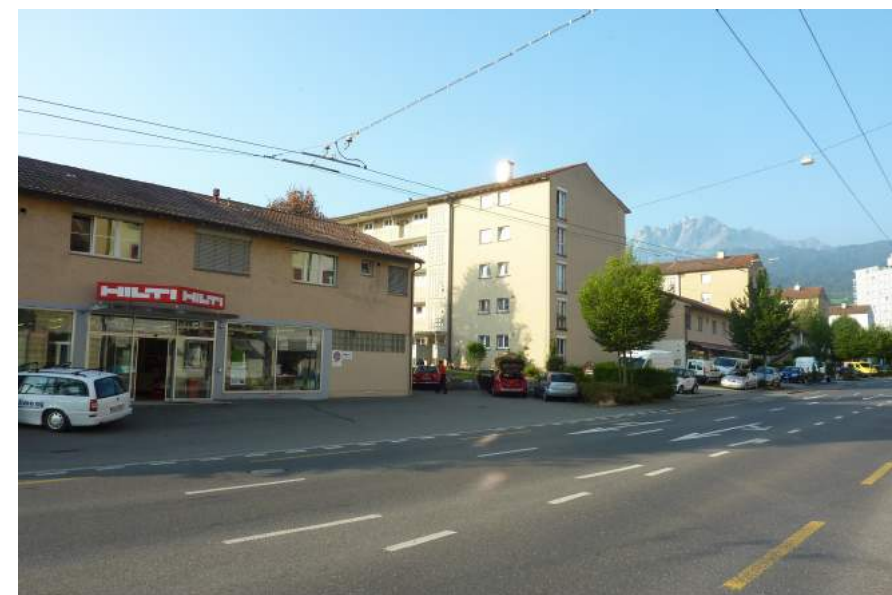
Grosshof, Luzernerstrasse, Ansicht von NO
