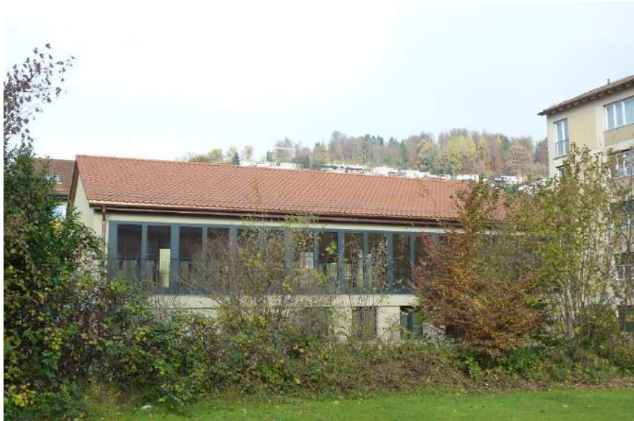
Luzernerstrasse 82, Ansicht von S (Aufnahme 2016)
