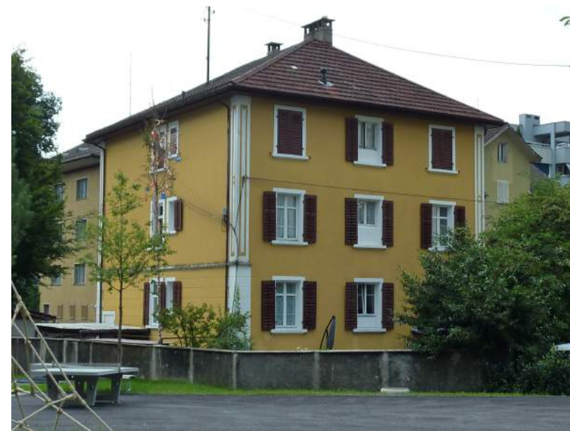
Schachenstrasse 7a, Gartenheim, Ansicht von NW
