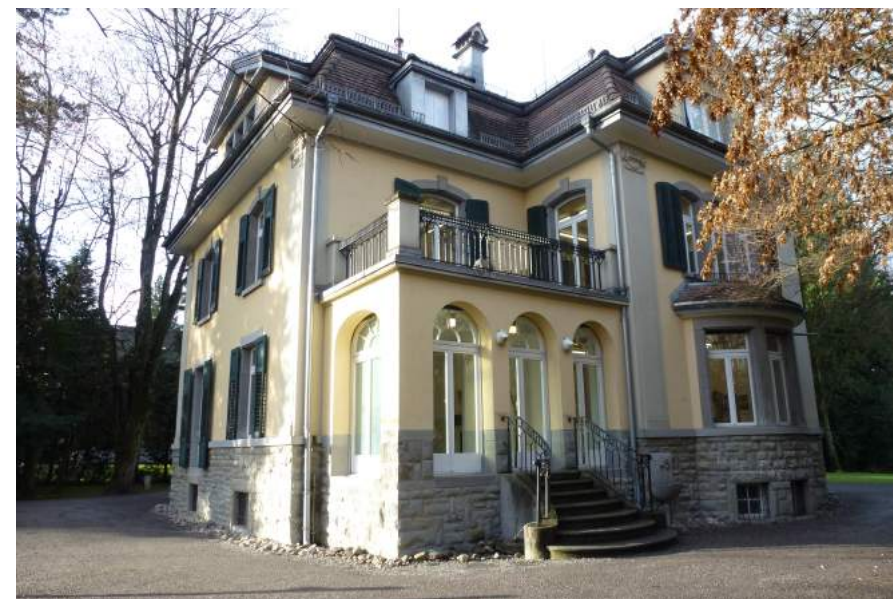
Luzernerstrasse 21, Villa Florida, Ansicht von SO
