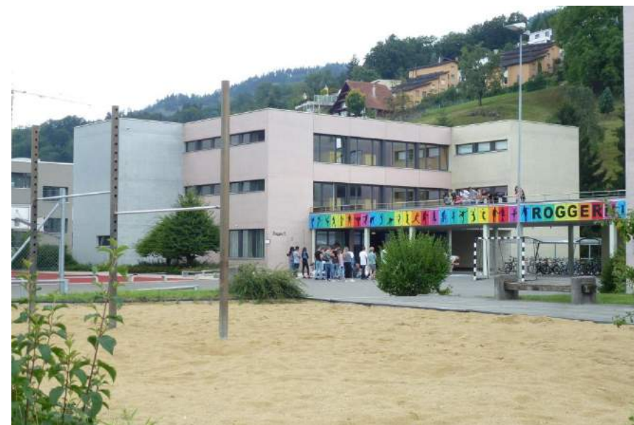
Schlundstrasse, Schulhaus Roggern 2, Ansicht von NO
