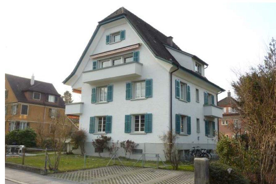
Brunnmattstrasse 3, Ansicht von SO
