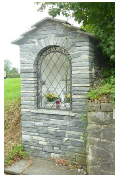
Hohle Gasse, Bildstock, Ansicht von NW
