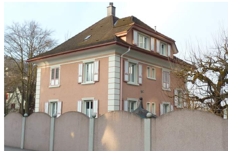
Luzernerstrasse 68, Sonnegg, Ansicht von SW
