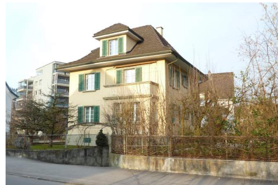
Hochrainstrasse 16, Ansicht von SW
