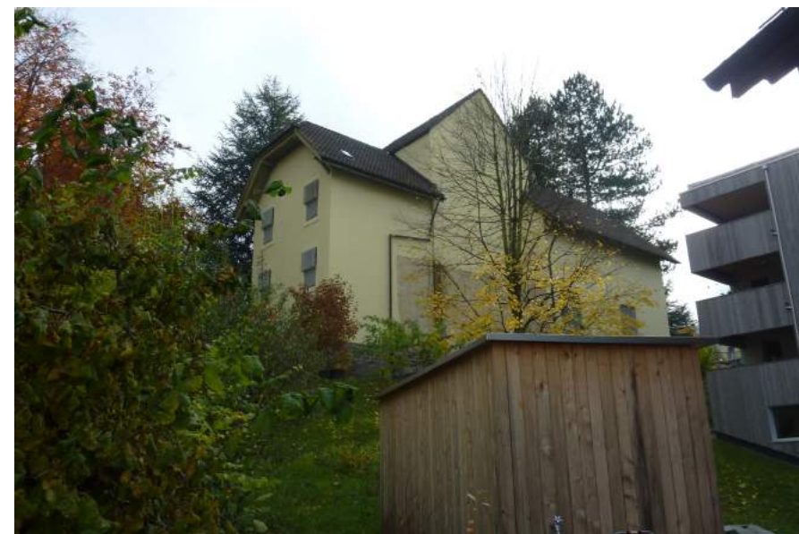
Kirchrainweg 6, EWL-Unterwerk Fenkern, Ansicht von NW (Aufnahme 2014)
