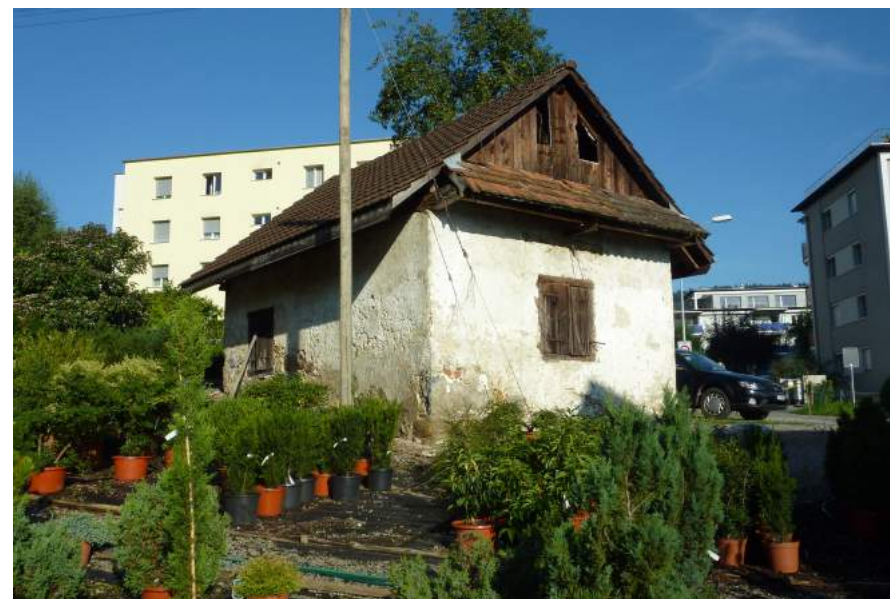
Talacker, Waschhaus, Ansicht von SO
