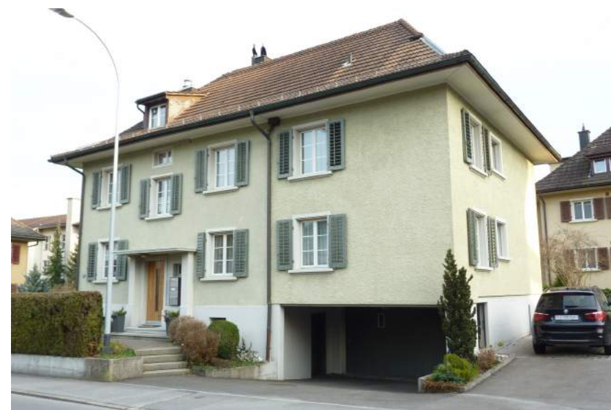
Hochrainstrasse 12, Ansicht von NW
