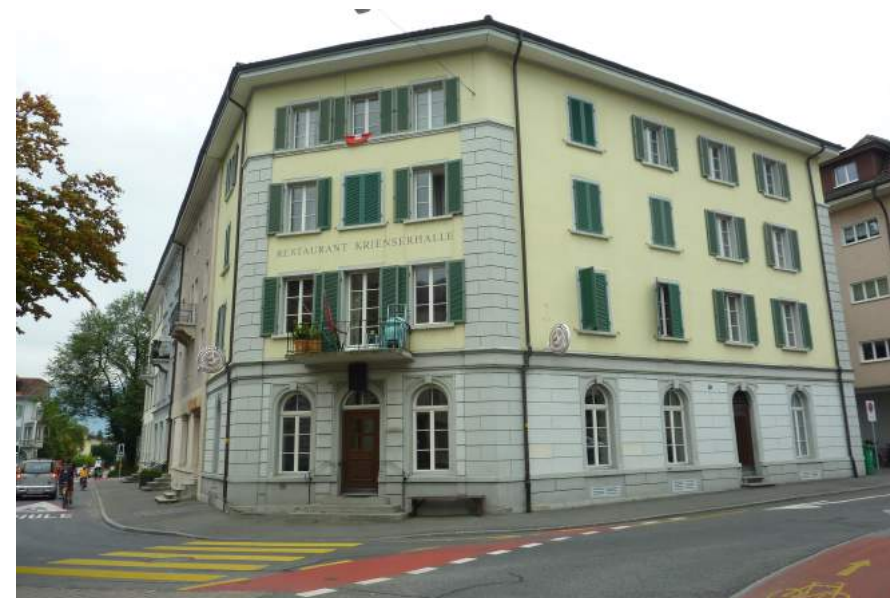
Gallusstrasse 14, Restaurant Krienserhalle, Ansicht von N
