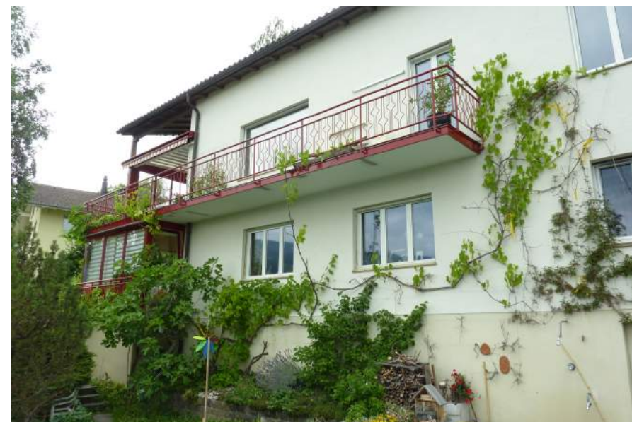
Sonnenweg 4, Ansicht von S
