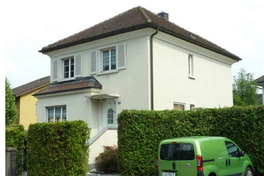
Hochrainstrasse 20, Ansicht von NW
