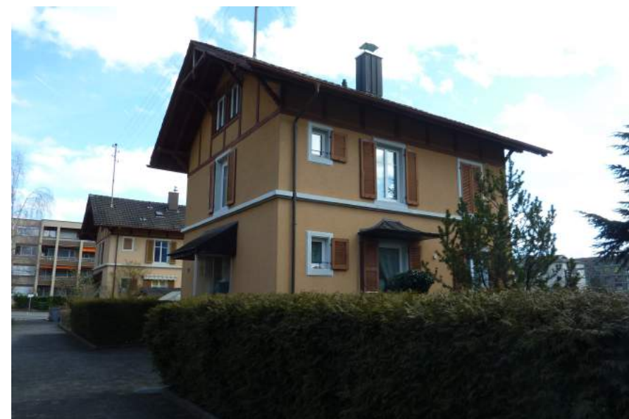
Birkenweg 3, Ansicht von NW
