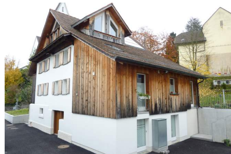
Kirchrainweg 4, Doggeliloch, Ansicht von W
