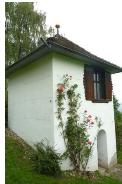
Schlossweg, Gartenpavillon, Ansicht von SW
