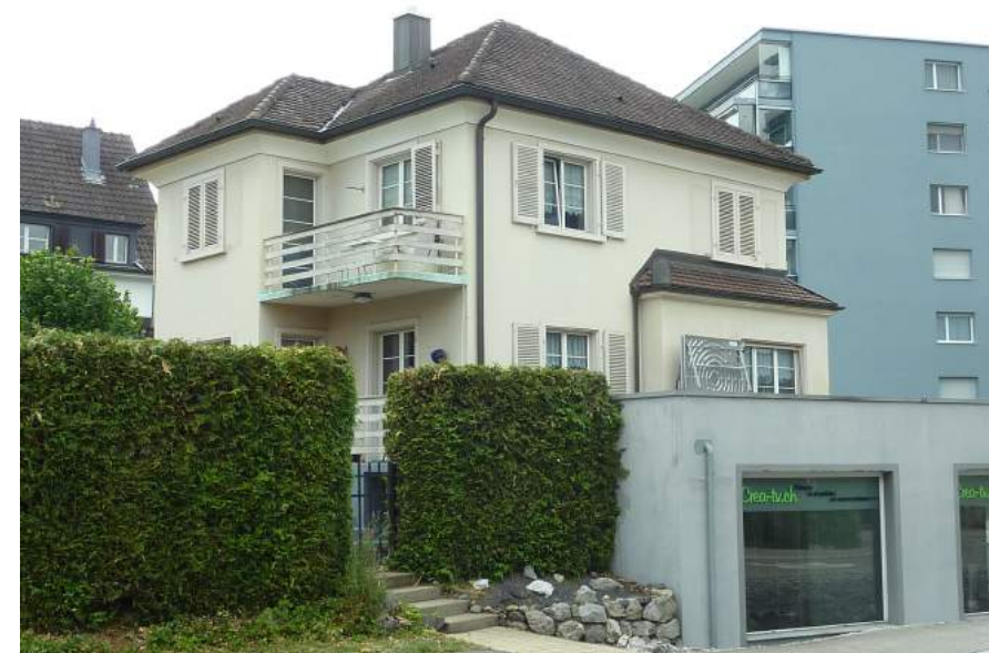
Hochrainstrasse 20, Ansicht von SO
