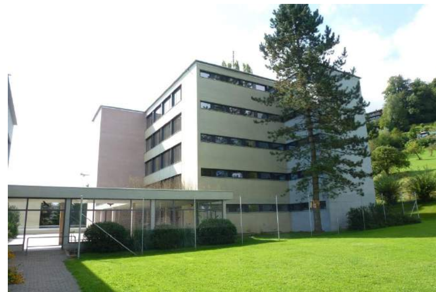
Schlundstrasse, Schulhaus Roggern 1, Ansicht von N
