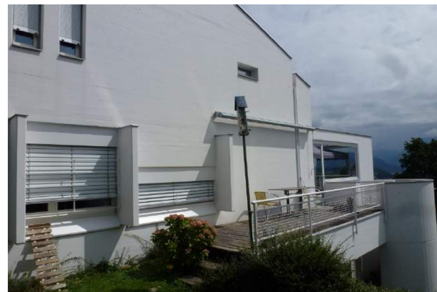
Obere Dattenbergstrasse 38, Ansicht von NW
