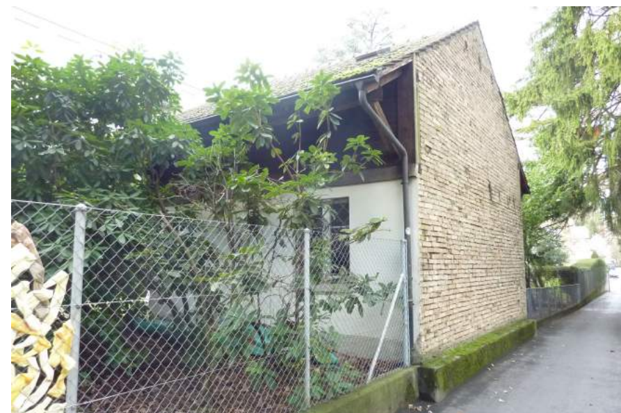
Güterstrasse, Nebengebäude, Ansicht von SO
