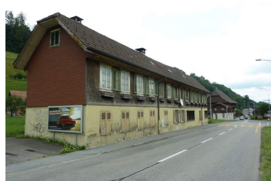
Obernau, Ansicht von W
