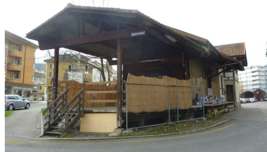
Güterstrasse, KLB-Bahnhof, Ansicht von NO (Aufnahme 2014)
