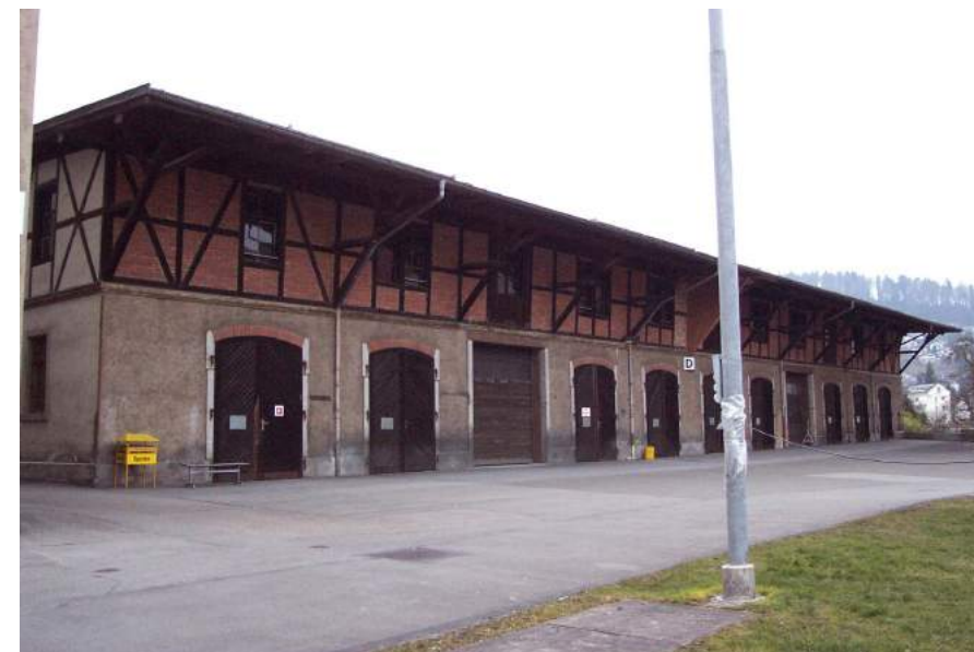
Arsenalstrasse, Führungsstaffeln, Ansicht von SO
