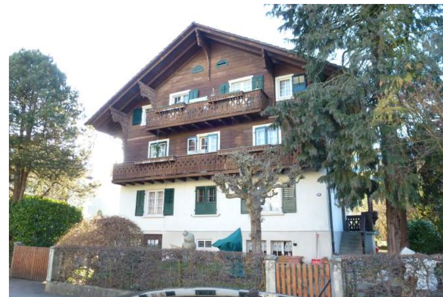
Pilatusstrasse 28, Chalet Elisa, Ansicht von O
