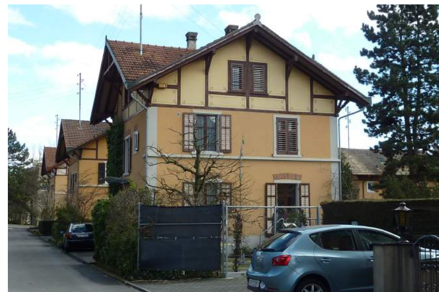
Erlenweg 5, Ansicht von W
