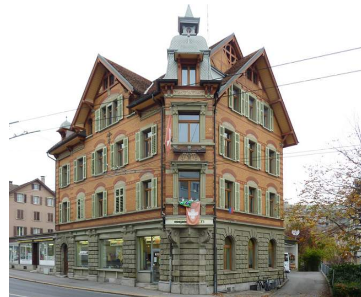
Luzernerstrasse 5, Alte Post, Ansicht von SO (Aufnahme 2014)
