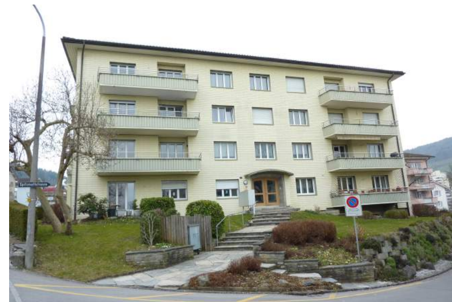
Spitzmattstrasse 1, Ansicht von O
