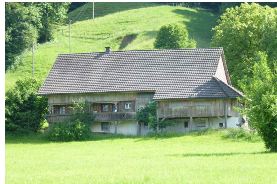
Hergiswaldstrasse, Ansicht von O
