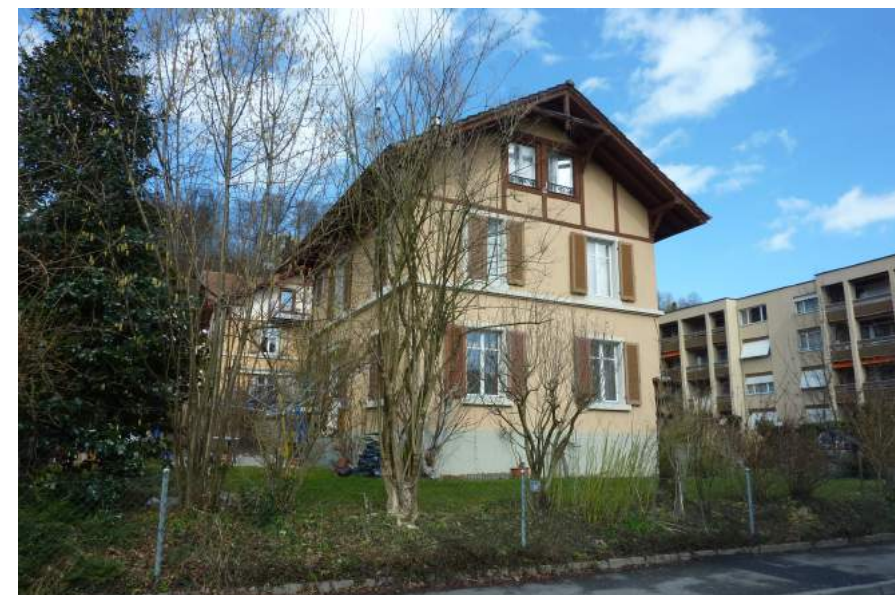
Birkenweg 1, Ansicht von SW
