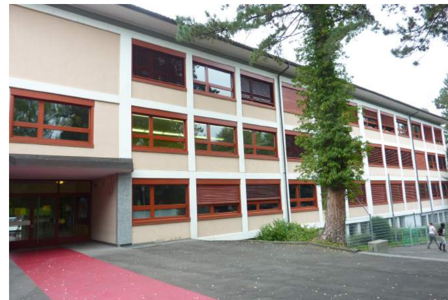
Kirchrainweg 8, Schulhaus Kirchbühl 2, Ansicht von S (Aufnahme 2014)
