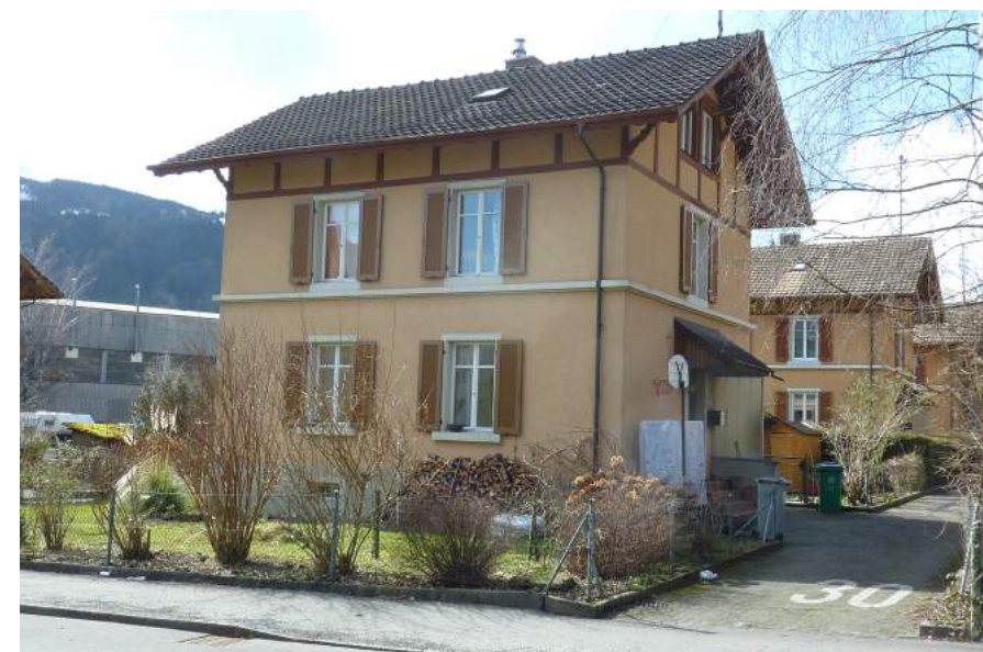
Birkenweg 1, Ansicht von NO
