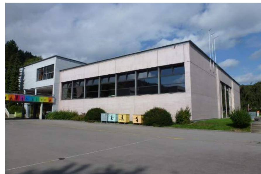
Schlundstrasse, Schulhaus Roggern, Turnhalle und Spezialtrakt, Ansicht von
