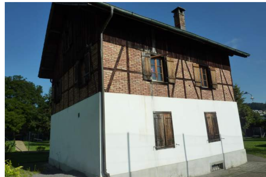
Schlundstrasse, Brennhaus, Ansicht von S
