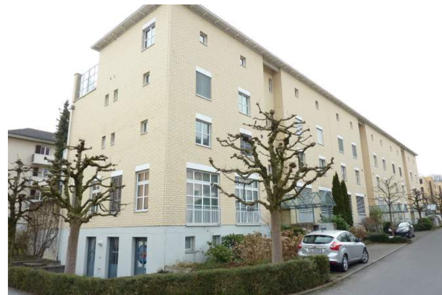
Pulvermühleweg 1, Ansicht von NO
