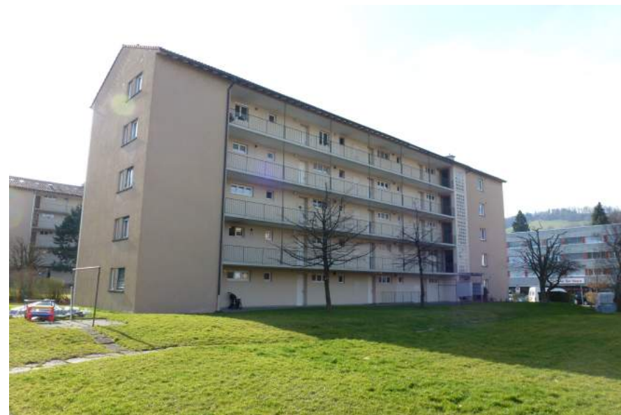
Luzernerstrasse 84, Ansicht von O
