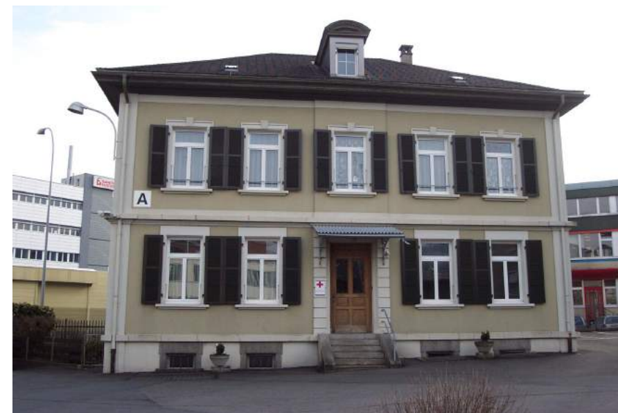
Arsenalstrasse, Verwaltungsgebäude, Ansicht von NW
