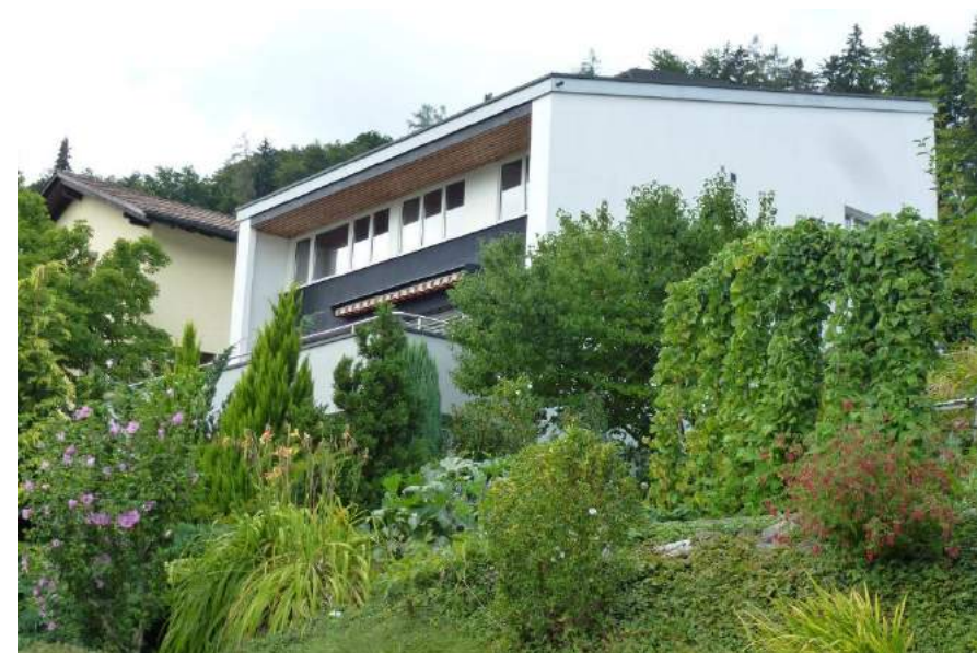
Sonnenbergstrasse 51, Ansicht von SO
