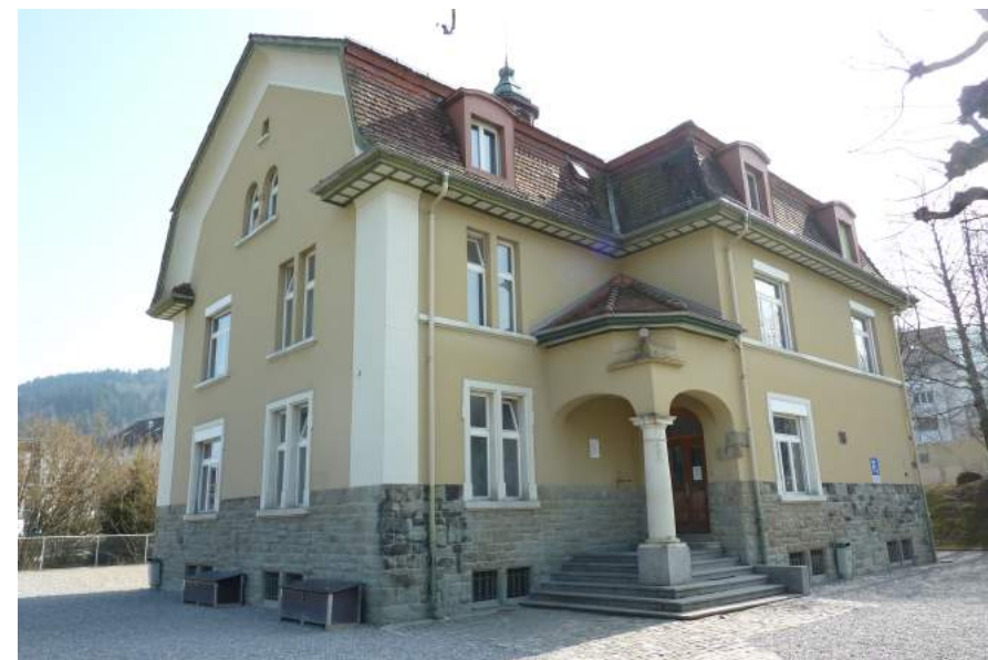
Hergiswaldstrasse 23, Schulhaus Obernau, Ansicht von NW
