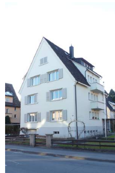
Alpenstrasse 36, Ansicht von NO
