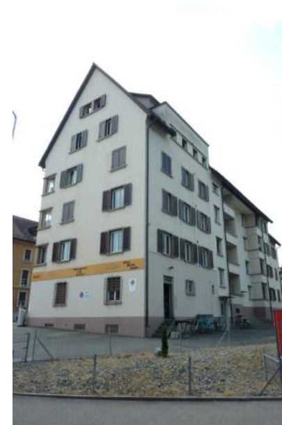
Luzernerstrasse 39, Ansicht von NO
