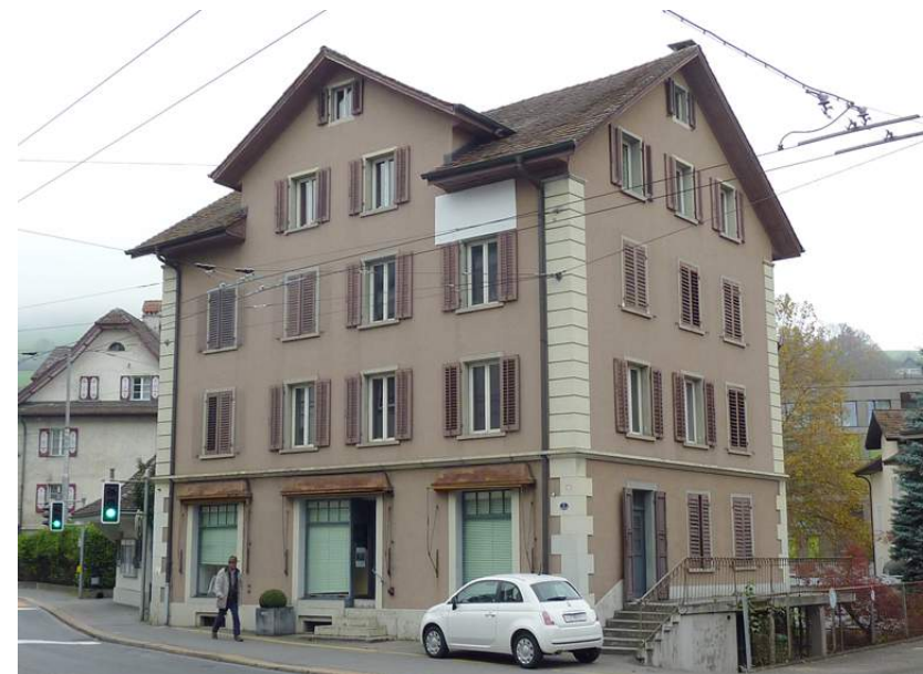
Luzernerstrasse 1, Ansicht von SO (Aufnahme 2014)
