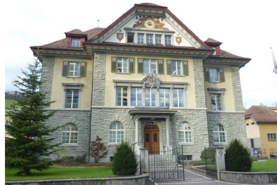
Schachenstrasse 13, Gemeindehaus, Ansicht von S
