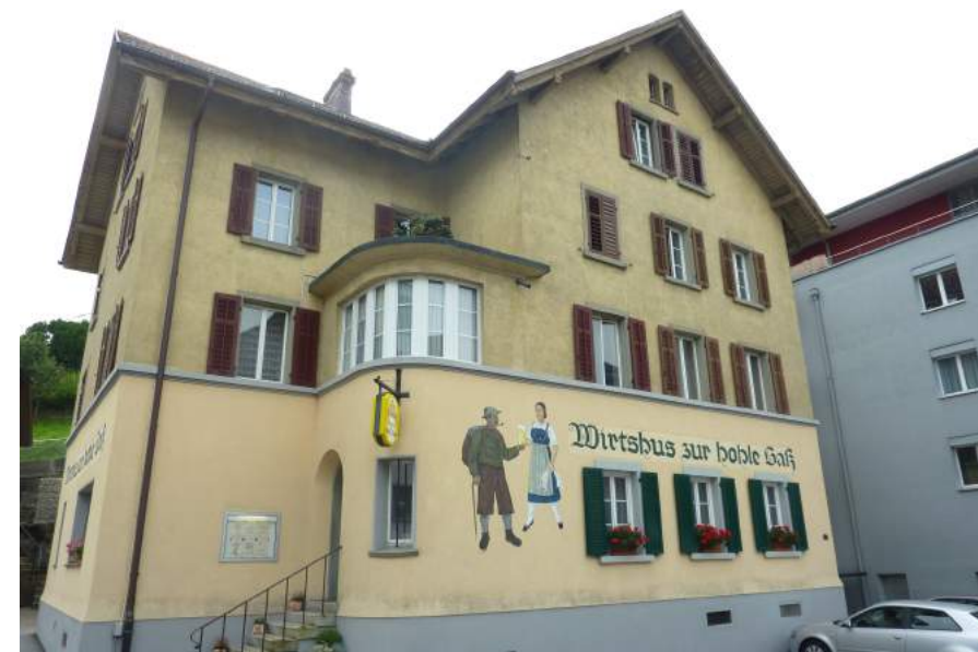
Hohle Gasse 2, Restaurant Hohle Gasse, Ansicht von W
