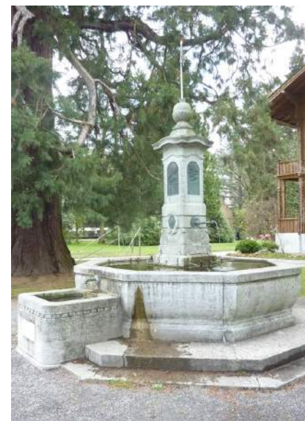
Luzernerstrasse, Dorfbrunnen, Ansicht von SO
