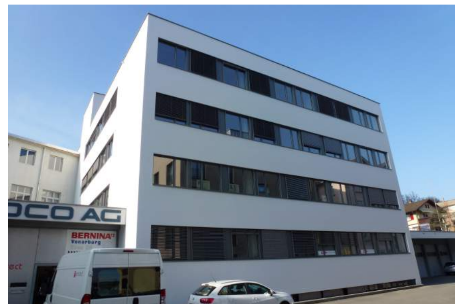
Sonnenbühlweg 1, Ansicht von SW
