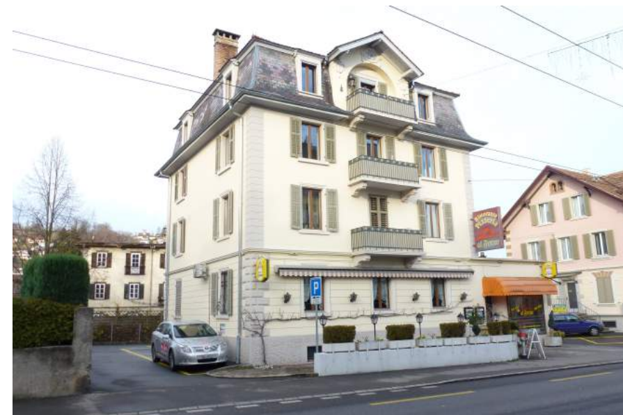
Luzernerstrasse 27, Frohalm II, Ansicht von SW
