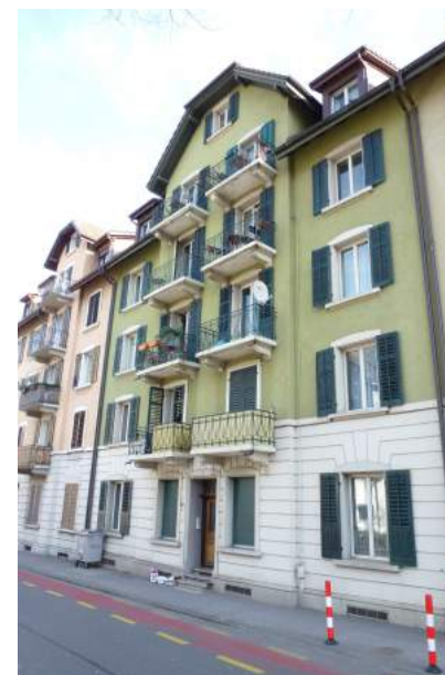
Amlehnstrasse 52, Ansicht von NW
