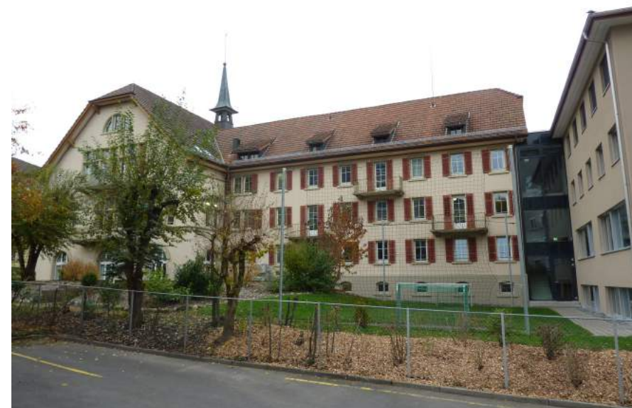
Fenkernstrasse 15, Saleshaus, Ansicht von SO
