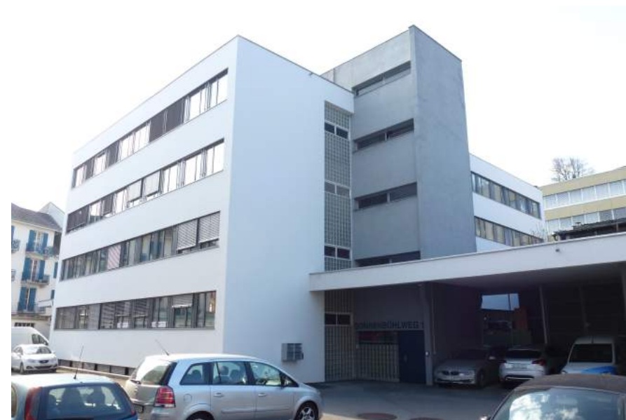
Sonnenbühlweg 1, Ansicht von SO
