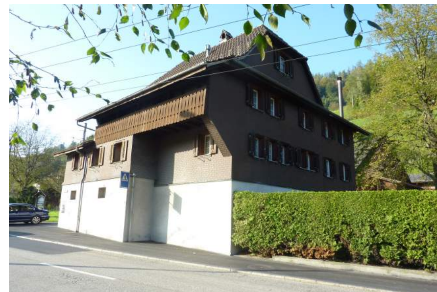
Obernauerstrasse 110, Nagelschmiede, Ansicht von SO
