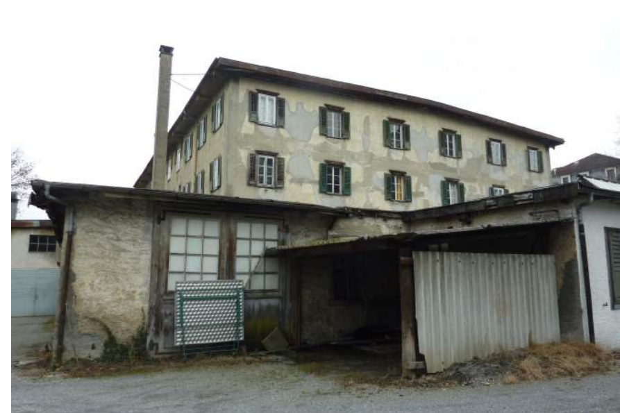
Luzernerstrasse 33 c, Alte Ziegelei, Ansicht von NW
