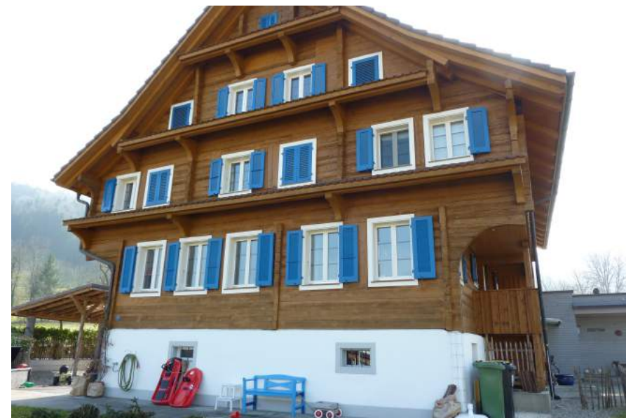
Hergiswaldstrasse 23, Ansicht von N
