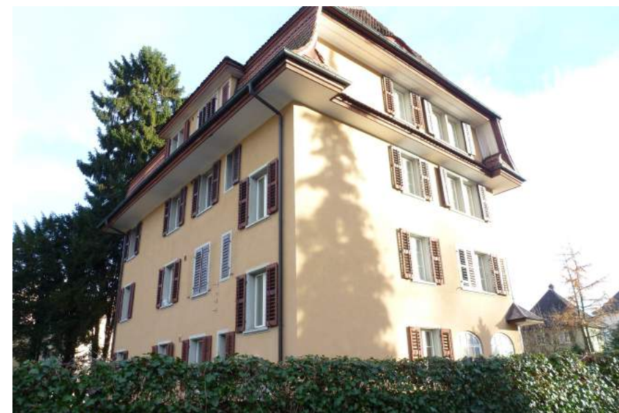
Luzernerstrasse 43, Ansicht von NW
