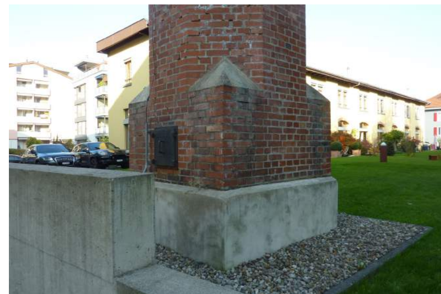
Pulvermühleweg, Hochkamin, Detail
