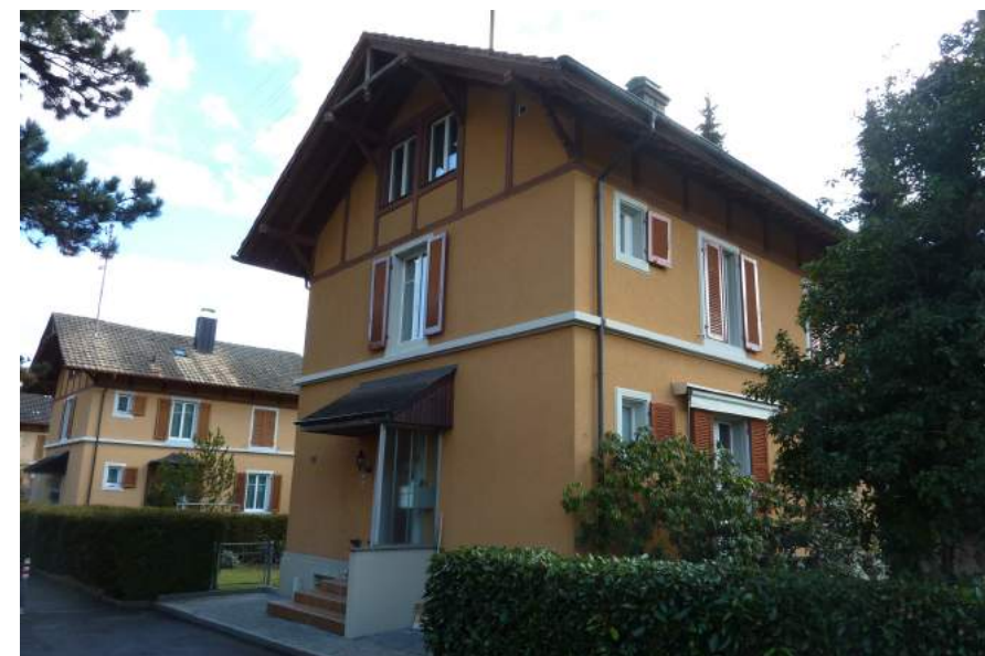
Birkenweg 5, Ansicht von NW
