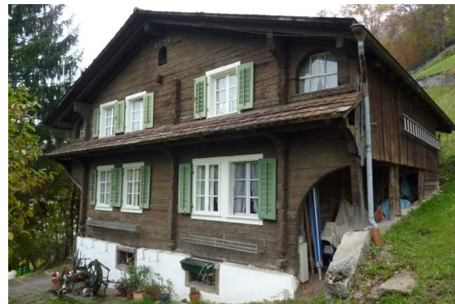
Obernauerstrasse 76, Geissenrain, Ansicht von O (Aufnahme 2014)
