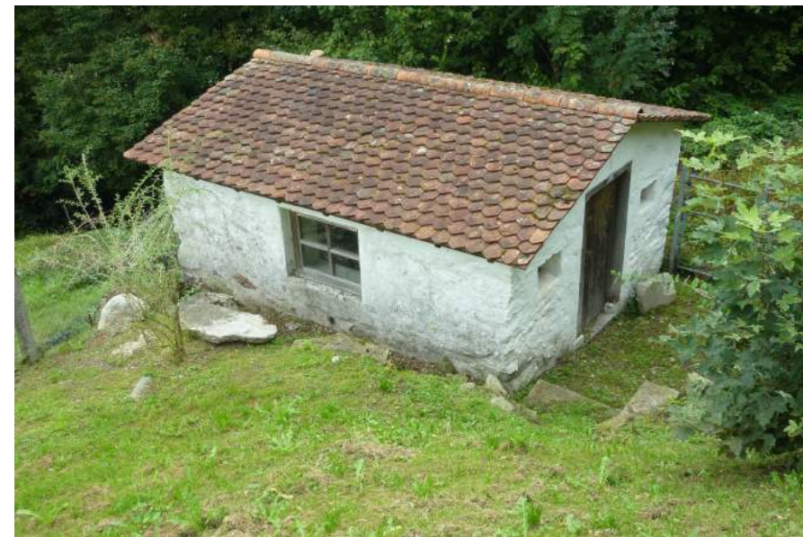
Schlossweg, Waschhaus, Ansicht von SW
