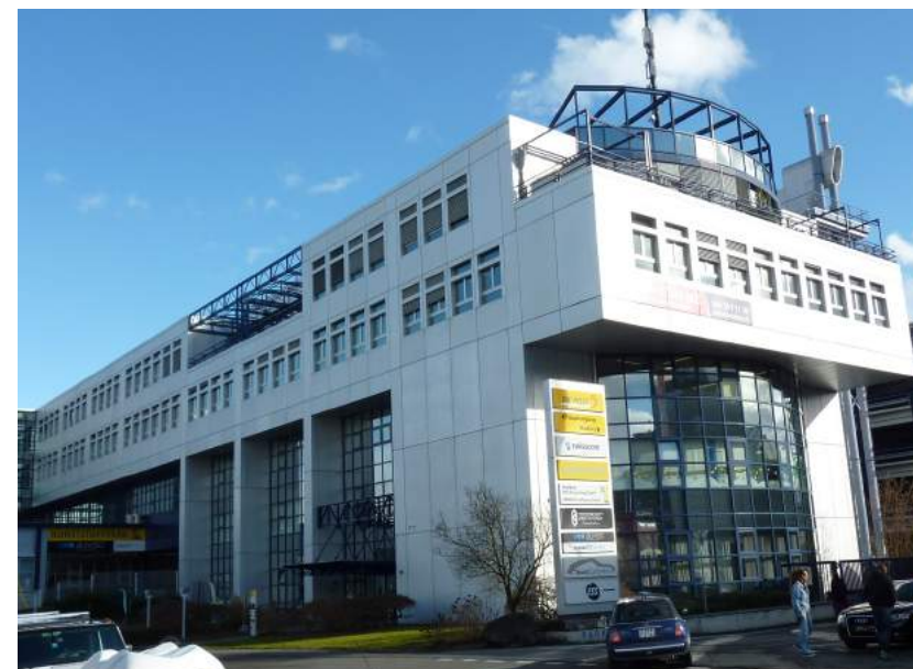
Sternmatt 6, Ansicht von NW
