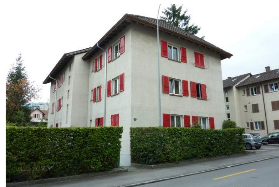
Schachenstrasse 32, Ansicht von NO
