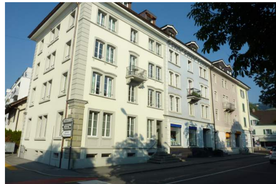
Horwerstrasse 4-8, Ansicht von SO
