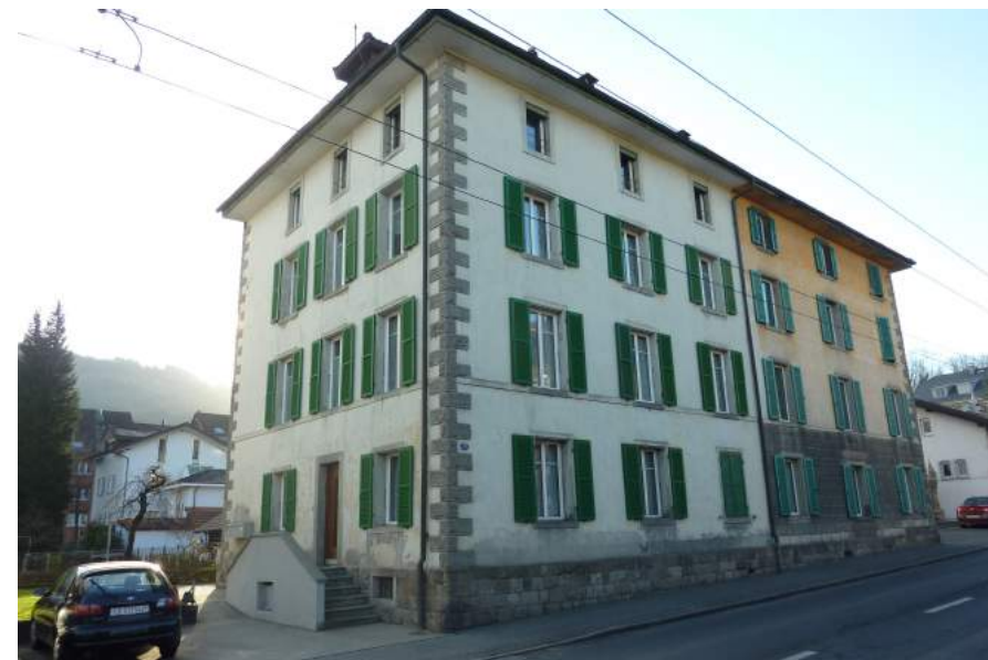
Obnauerstrasse 37, Ansicht von NO
