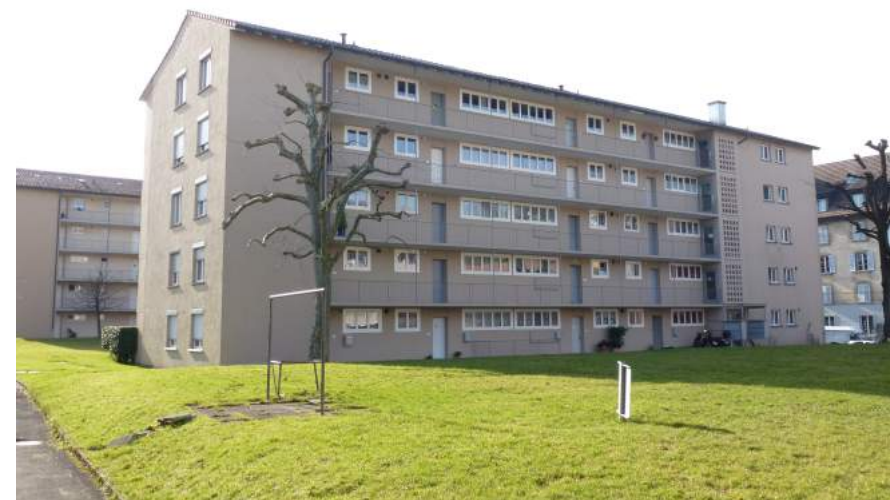
Luzernerstrasse 88, Ansicht von O
