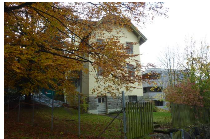
Kirchrainweg 6, EWL-Unterwerk Fenkern, Ansicht von NO (Aufnahme 2014)
