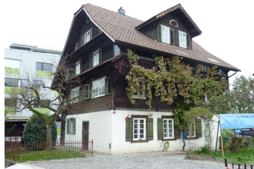
Luzernerstrasse 35, Bachmättli, Ansicht von SW
