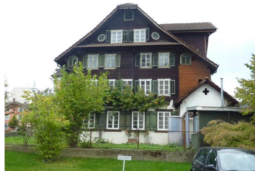
Luzernerstrasse 35, Bachmättli, Ansicht von O
