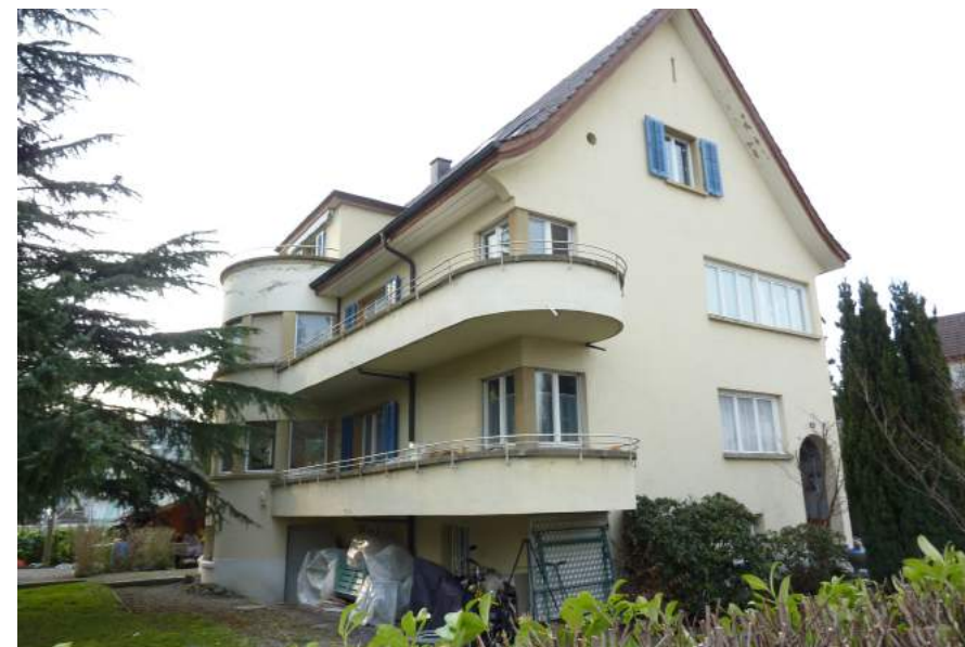
Pilatusstrasse 10, Ansicht von SO
