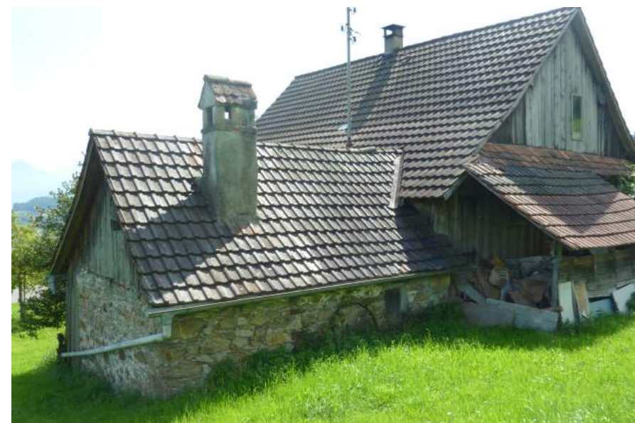
Schattenbergstrasse, Obermettlen, Ansicht von NW
