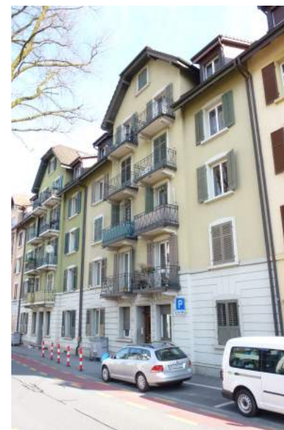
Amlehnstrasse 50, Ansicht von NW
