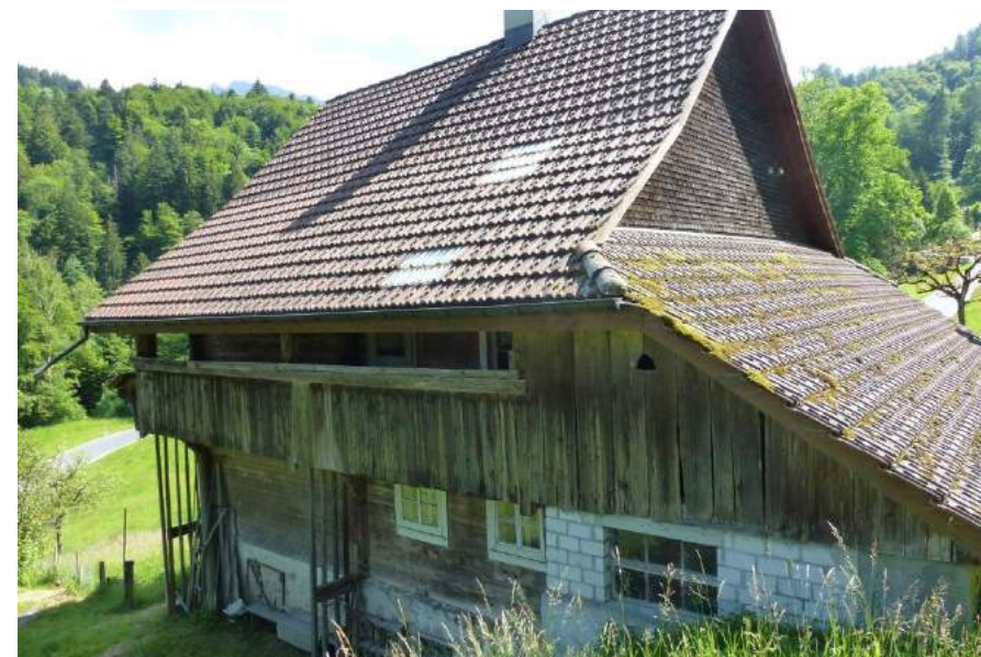
Hergiswaldstrasse, Stalden, Ansicht von N
