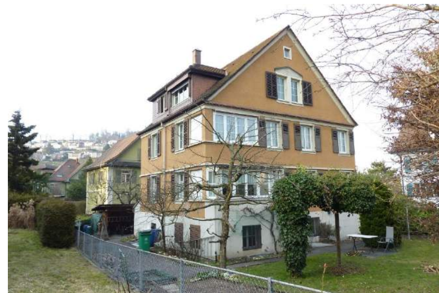
Brunnmattstrasse 4, Ansicht von SW
