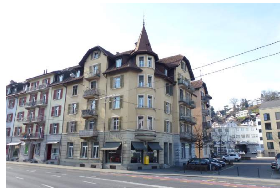
Luzernerstrasse 73, Ansicht von O
