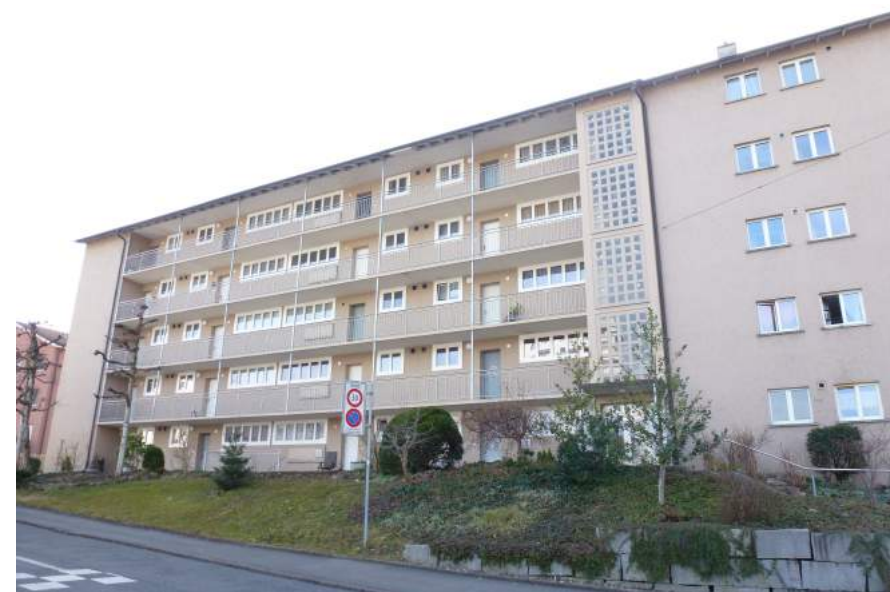
Luzernerstrasse 92, Ansicht von NO
