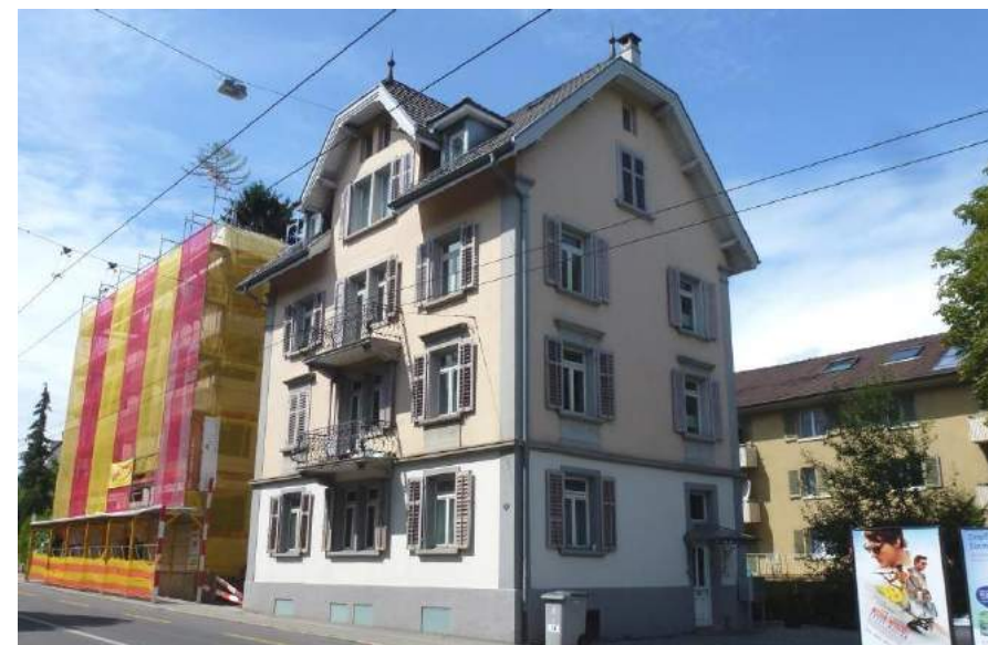
Luzernerstrasse 47, Ansicht von SO
