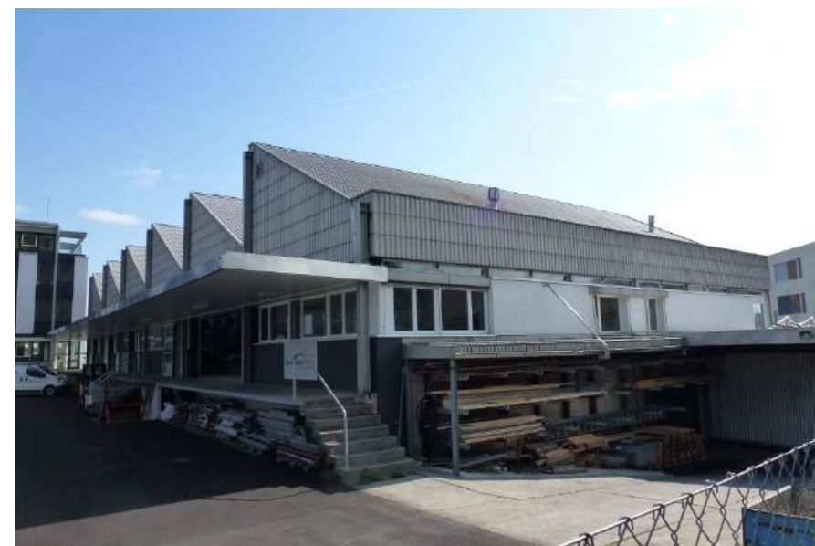
Horwerstrasse 60, Werkstattgebäude, Ansicht von
