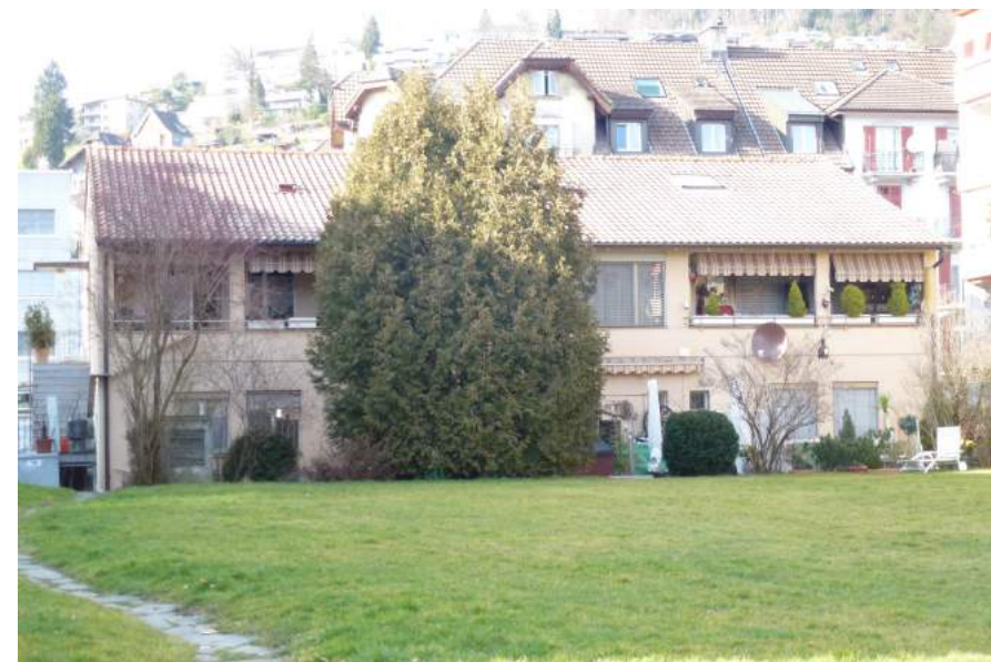
Luzernerstrasse 90, Ansicht von SO
