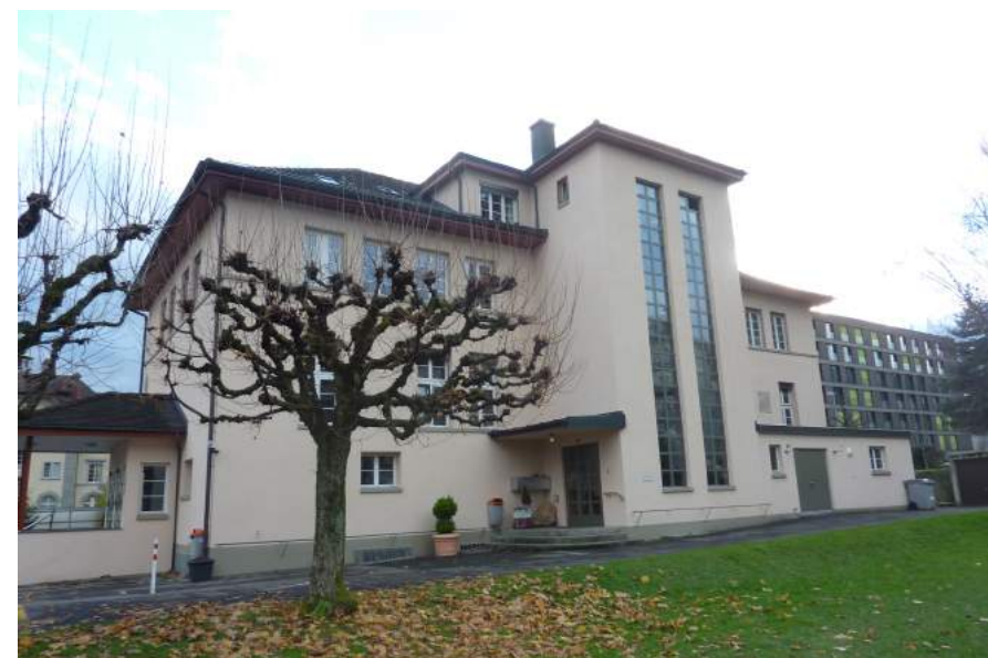
Gemeindehausstrasse 9, Gallusheim, Ansicht von NO
