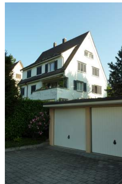
Lopperstrasse 4, Ansicht von
