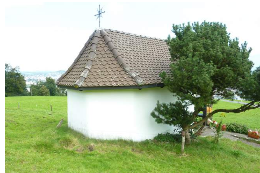
Schattenbergstrasse, Kapelle Ebersrüti, Ansicht von SW
