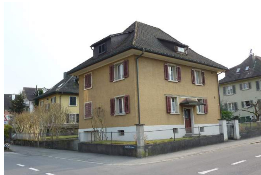
Hochrainstrasse 14, Ansicht von NO
