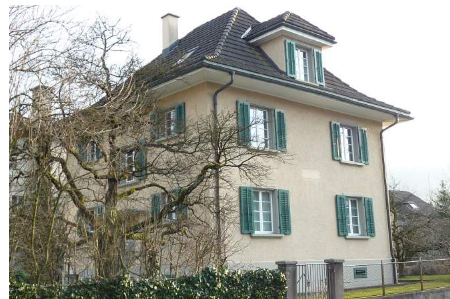
Hochrainstrasse 16, Ansicht von NO
