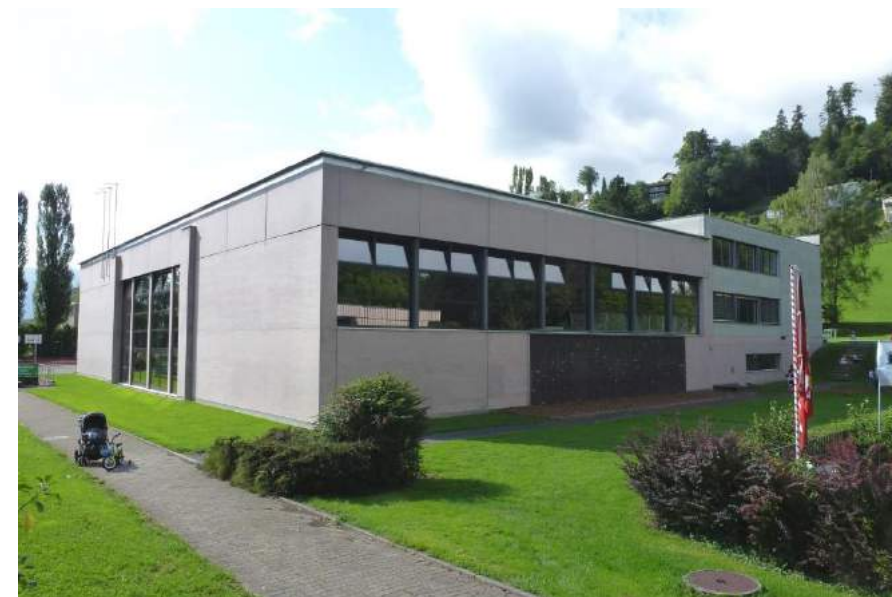
Schlundstrasse, Schulhaus Roggern, Turnhalle und Spezialtrakt, Ansicht von N
