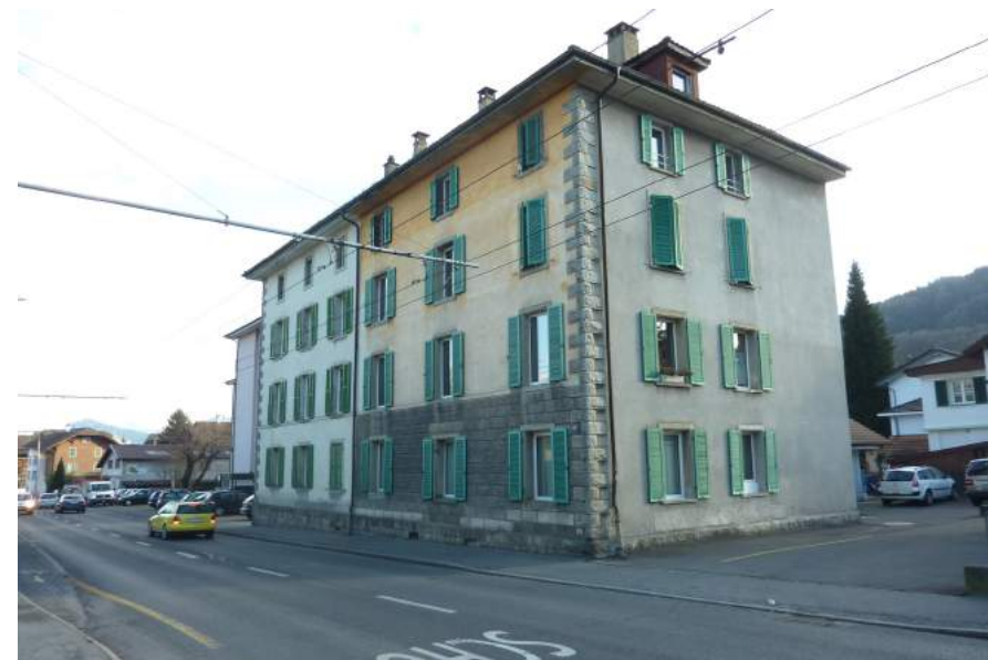
Obnauerstrasse 37 a, Ansicht von NW
