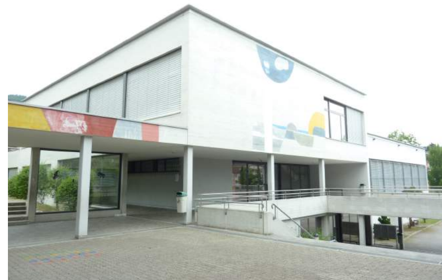
Südstrasse, Spezialtrakt, Ansicht von S
