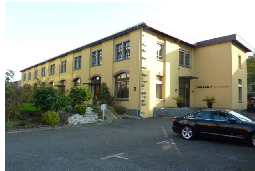
Pulvermühleweg 12, ehem. Hauptgebäude Lachappelle, Ansicht von NW
