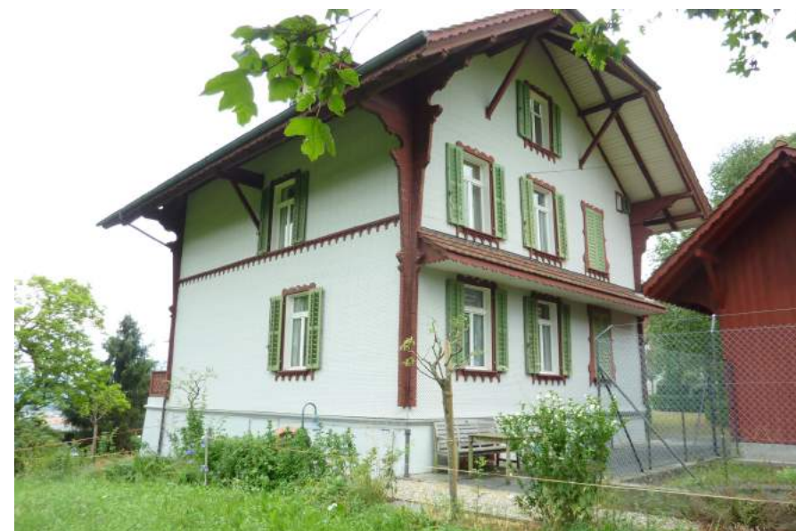
Sentistrasse, Ansicht von NW
