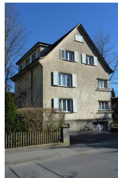
Alpenstrasse 21, Ansicht von NW
