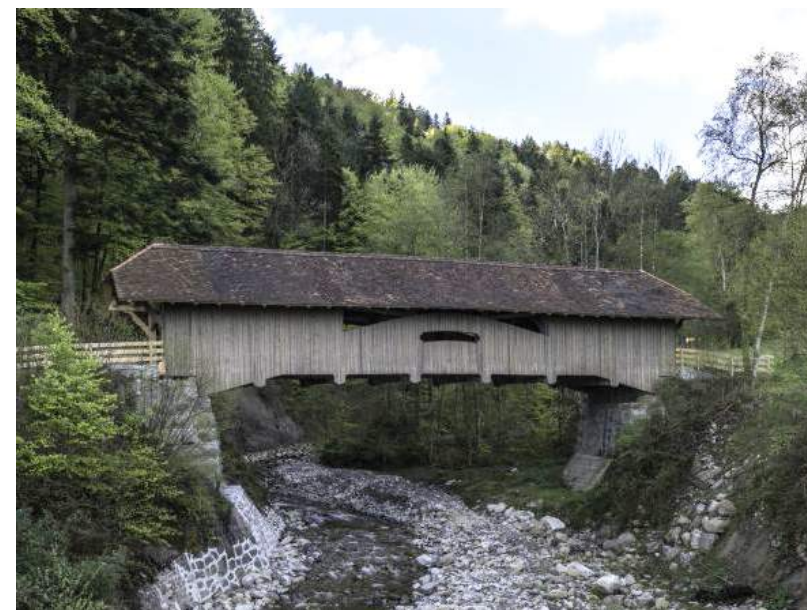
Hergiswaldbrücke, Ansicht von NW (Aufnahme 2016)
