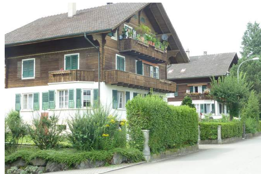
Chalet-Siedlung Pilatusstrasse, Ansicht von S
