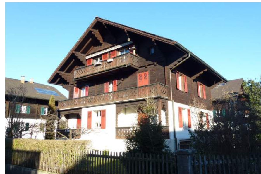
Pilatusstrasse 23, Ansicht von SW
