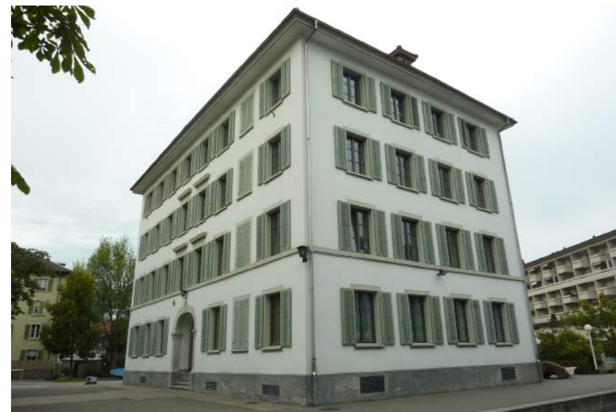
Horwerstrasse 3, Dorfschulhaus, Ansicht von S
