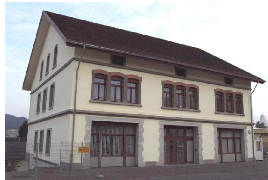
Arsenalstrasse, Kommandogebäude, Ansicht von NW
