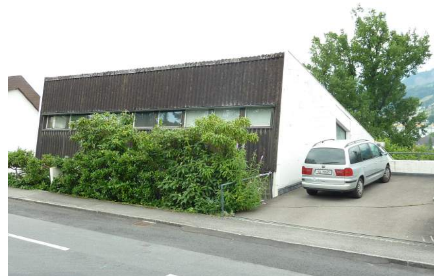
Bergstrasse 28, Ansicht von NW
