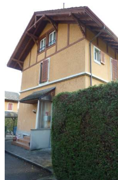
Birkenweg 7, Ansicht von NW
