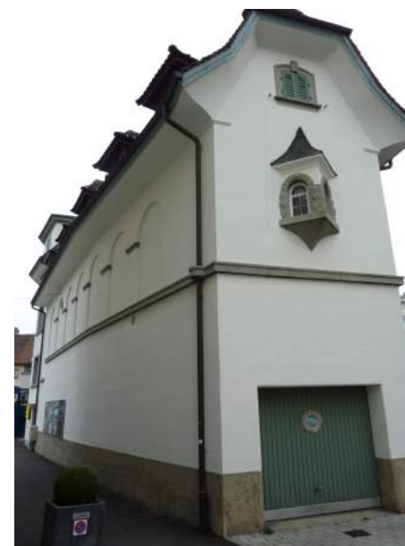
Fenkernstrasse 6a, Ansicht von NW
