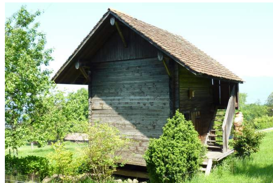
Eggenhof, Kornspeicher, Ansicht von SW
