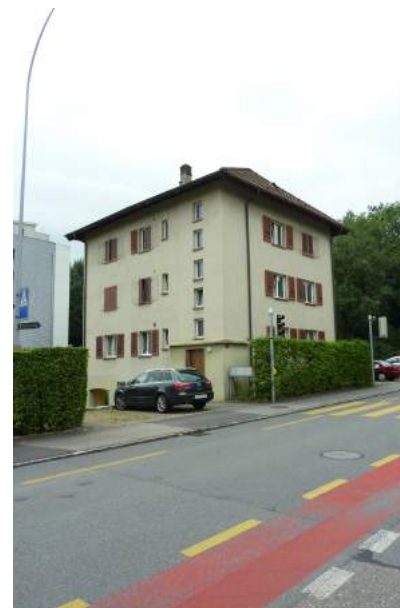
Schachenstrasse 26, Ansicht von NO
