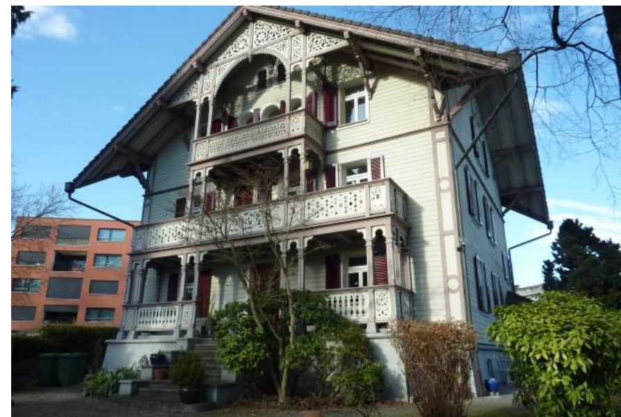
Horwerstrasse 13, Villa Grossfeld, Ansicht von SO
