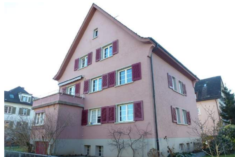
Brünigstrasse 1, Ansicht von NO
