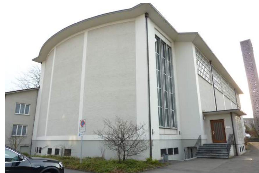
Pilatusstrasse 11, Bruder-Klaus Kirche, Ansicht von NO
