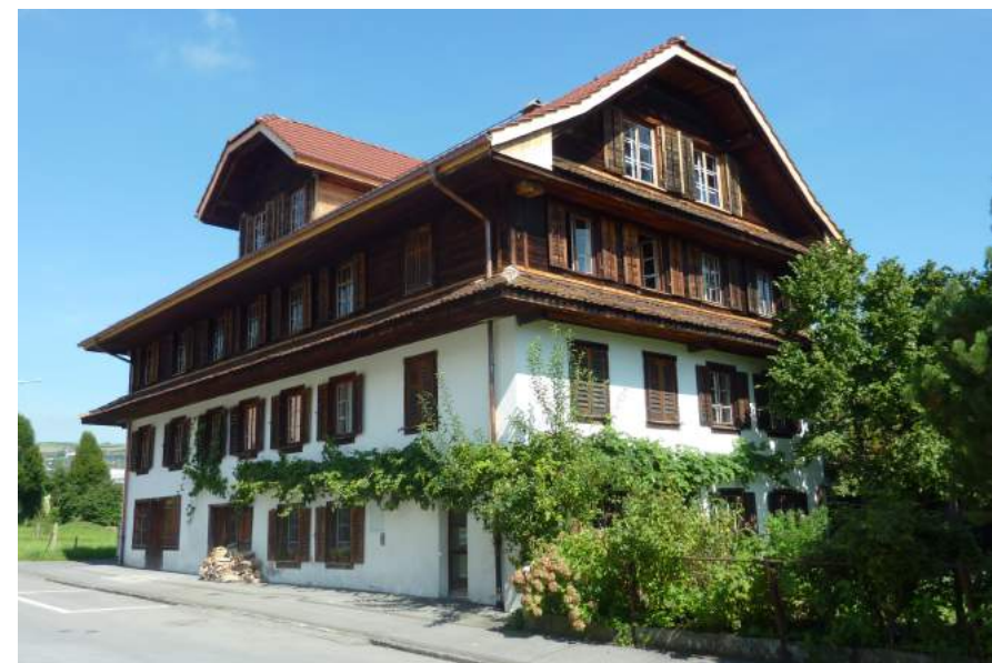
Horwerstrasse 85, Ansicht von S
