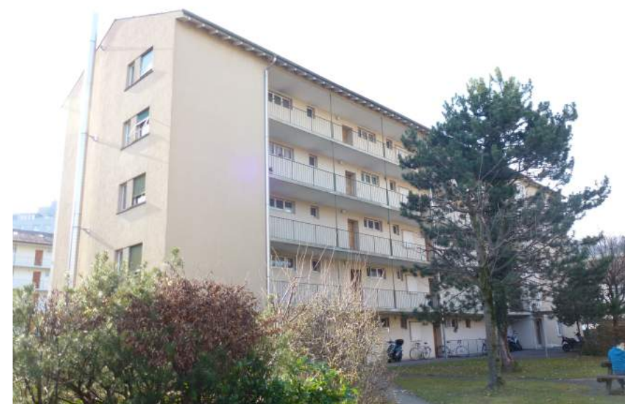
Luzernerstrasse 80, Ansicht von O
