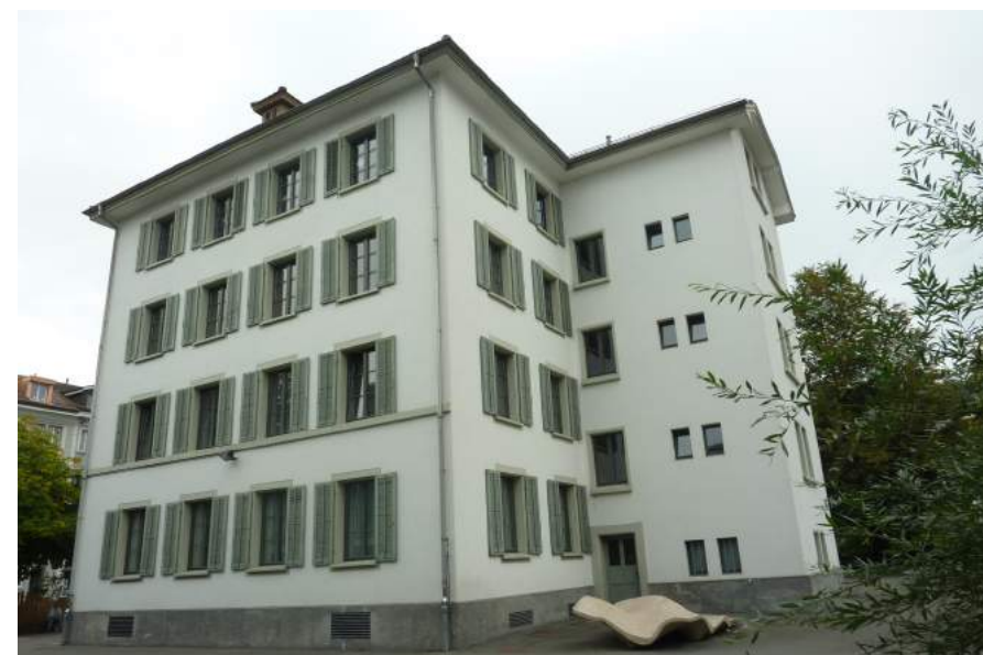
Horwerstrasse 3, Dorfschulhaus, Ansicht von N
