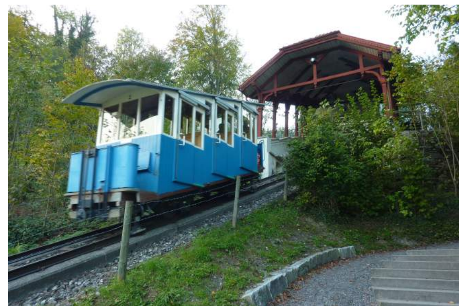
Sonnenberg, Bergstation Sonnenbergbahn, Ansicht von SO
