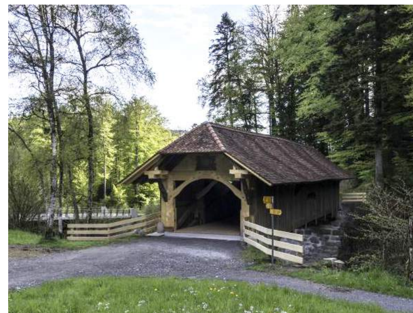
Hergiswaldbrücke, Ansicht von S (Aufnahm 2016)
