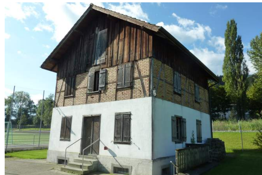
Schlundstrasse, Brennhaus, Ansicht von N
