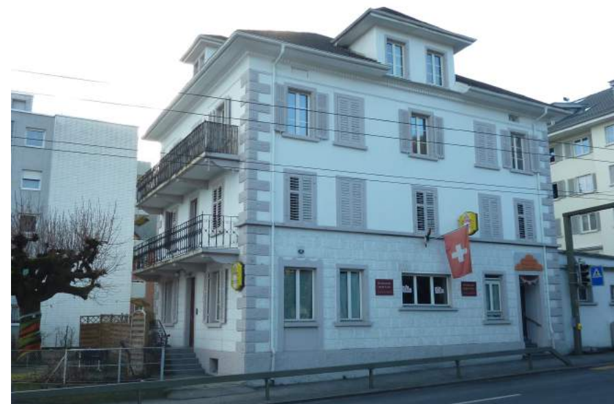
Obernauerstrasse 41, Restaurant Minerva, Ansicht von NO
