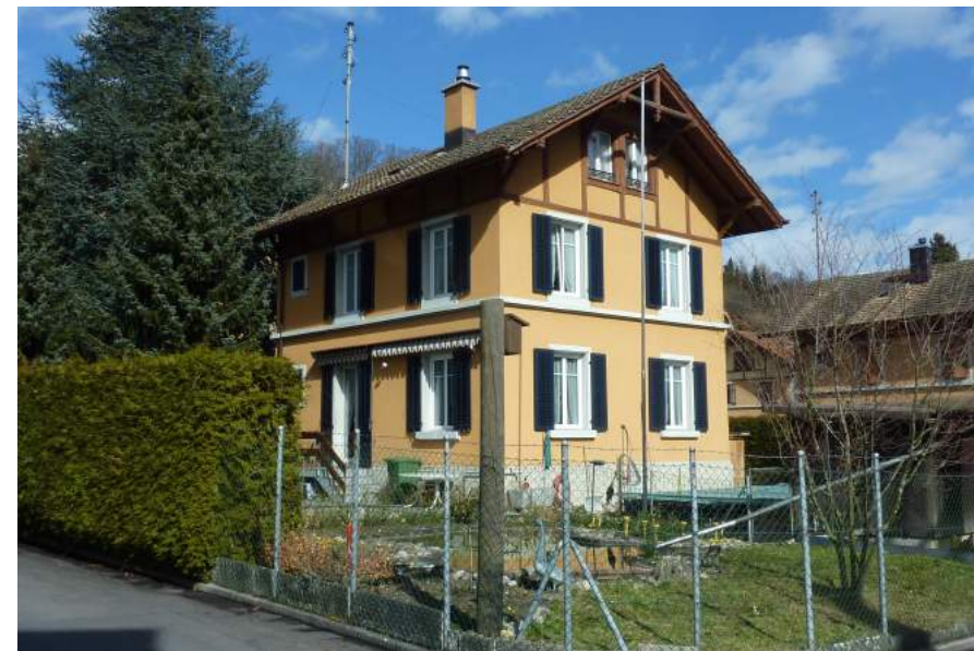
Birkenweg 9, Ansicht von SW
