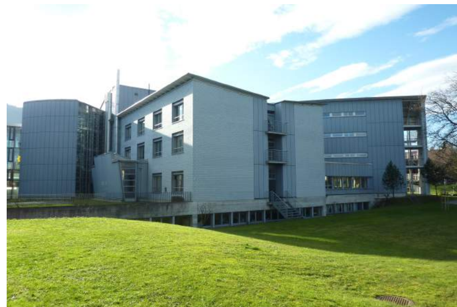
Horwerstrasse 33, Alters- und Pflegeheim Zunacher, Ansicht von NO
