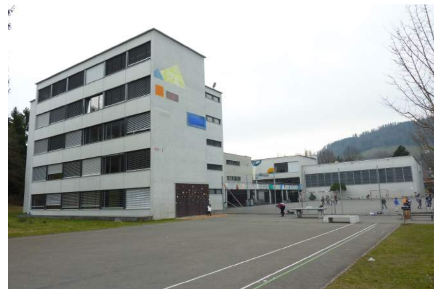
Südstrasse, Schulhaus Meiersmatt 2, Ansicht von O
