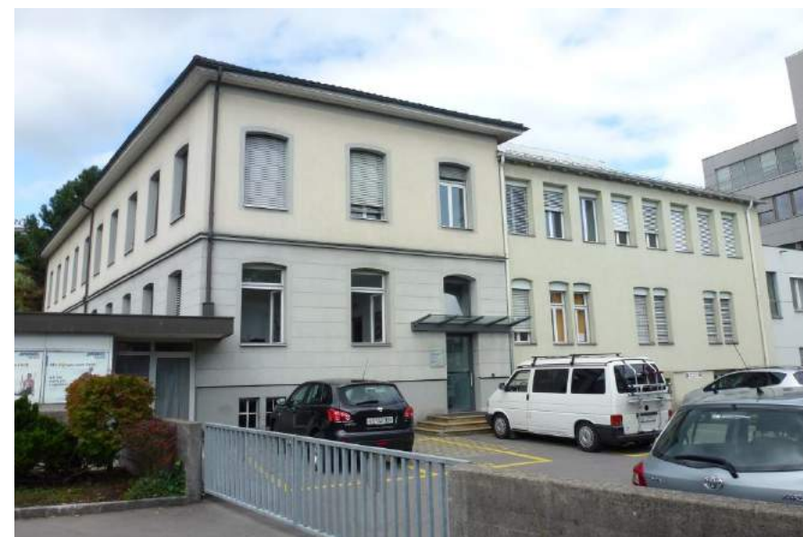
Obernauerstrasse 8, Verwaltungsgebäude Maschinenfabrik Bell AG, Ansicht von O
