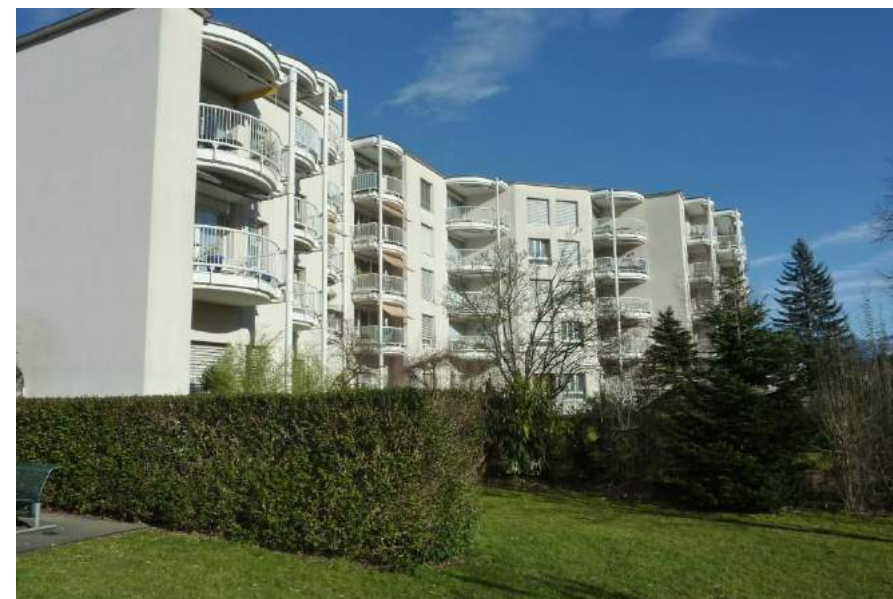
Hofmattweg 6/8, Ansicht von SW
