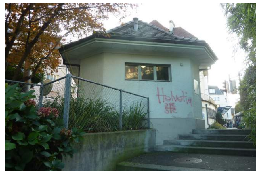
Luzernerstrasse, WC-Anlage Busschleife, Ansicht von NO
