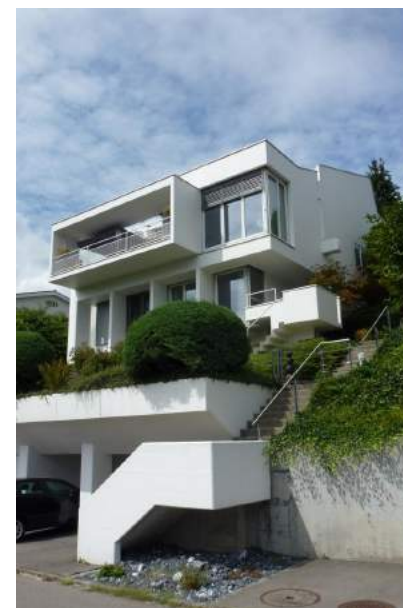
Obere Dattenbergstrasse 38, Ansicht von SO
