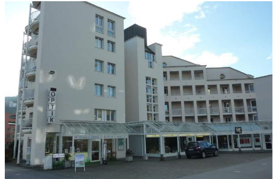
Zentrum Hofmatt 4, Ansicht von NO
