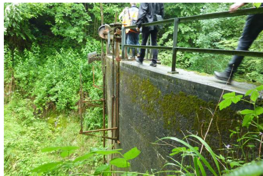
Hinter-Katzenbalg, Staumauer Bellenweiher, Ansicht von O
