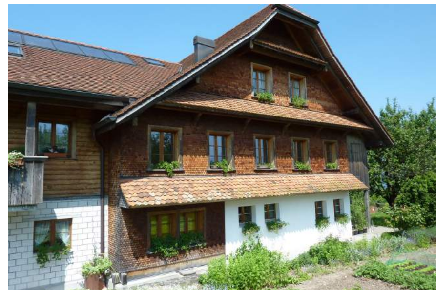
Eggenhof, Ansicht von SW
