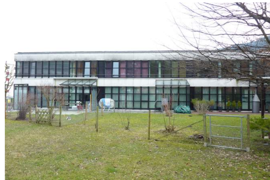
Hackenrainstrasse 4, Ansicht von NW
