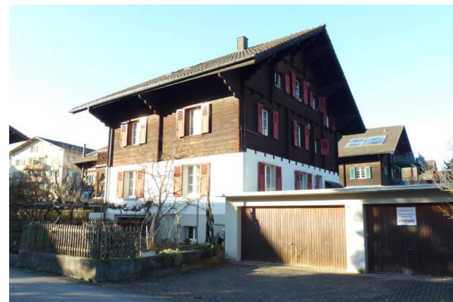
Pilatusstrasse 23, Ansicht von SO
