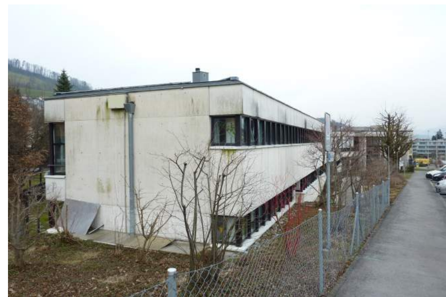
Hackenrainstrasse 4, Ansicht von SW
