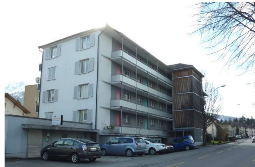
Amlehnstrasse 20, Ansicht von NO
