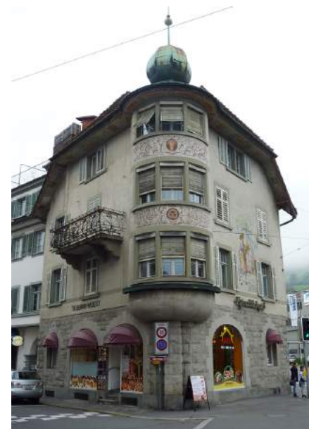
Fenkernstrasse 2, Neu-Kreuzbäckerei, Ansicht von O
