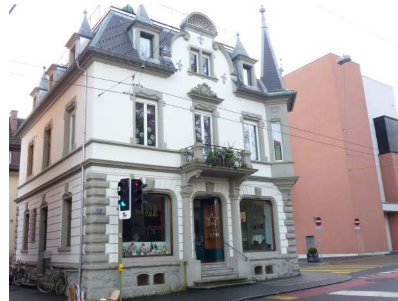
Luzernerstrasse 32, Ansicht von NO
