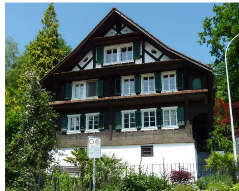
Zumhofstrasse 13, Mühlirain, Ansicht von S
