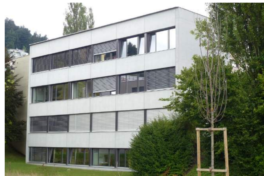
Schlundstrasse, Schulhaus Roggern 2, Ansicht von SO
