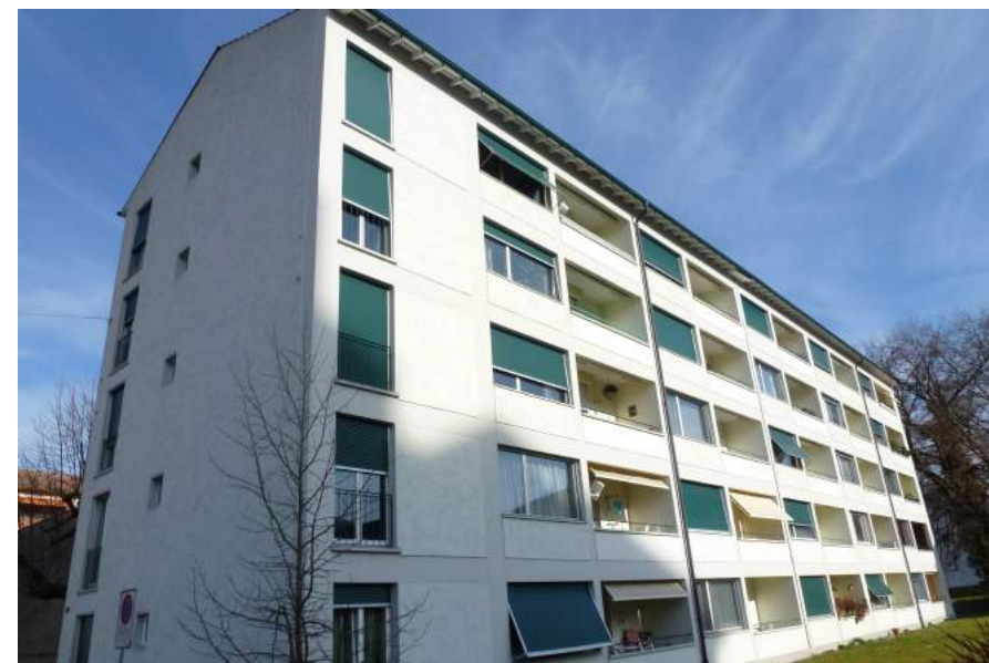
Luzernerstrasse 76, Ansicht von NW
