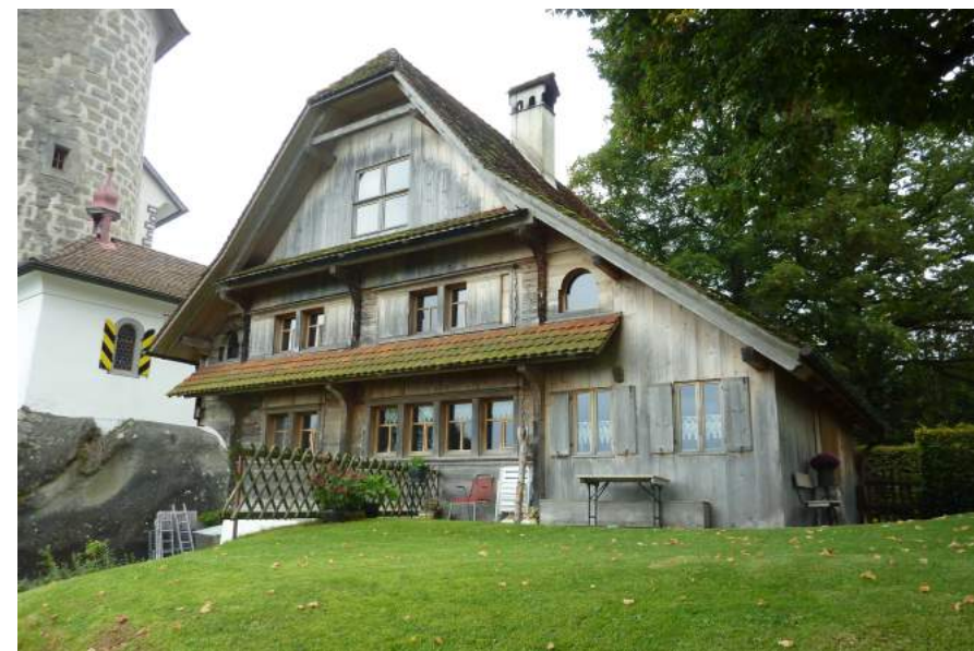
Schlossweg, Pförtnerhaus, Ansicht von NW
