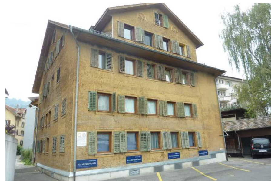
Gallusstrasse 5, Altbreithaus, Ansicht von NO
