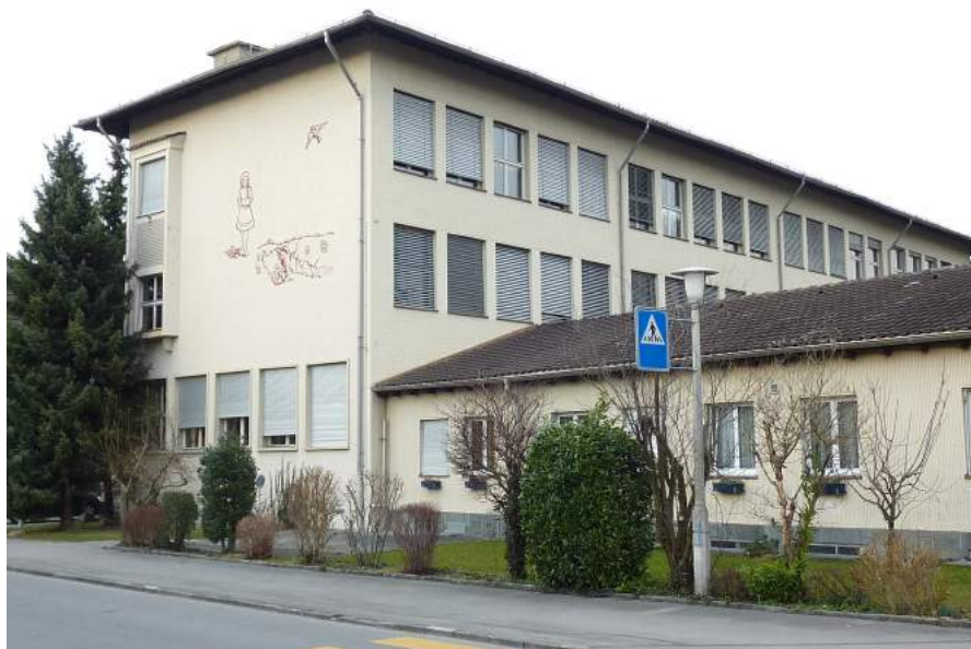
Brunnmattstrasse, Schulhaus Brunnmatt, Schultrakt und Pausenhalle, Ansicht von SW
