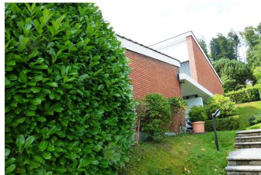
Steinhofhalde 17, Ansicht von SO
