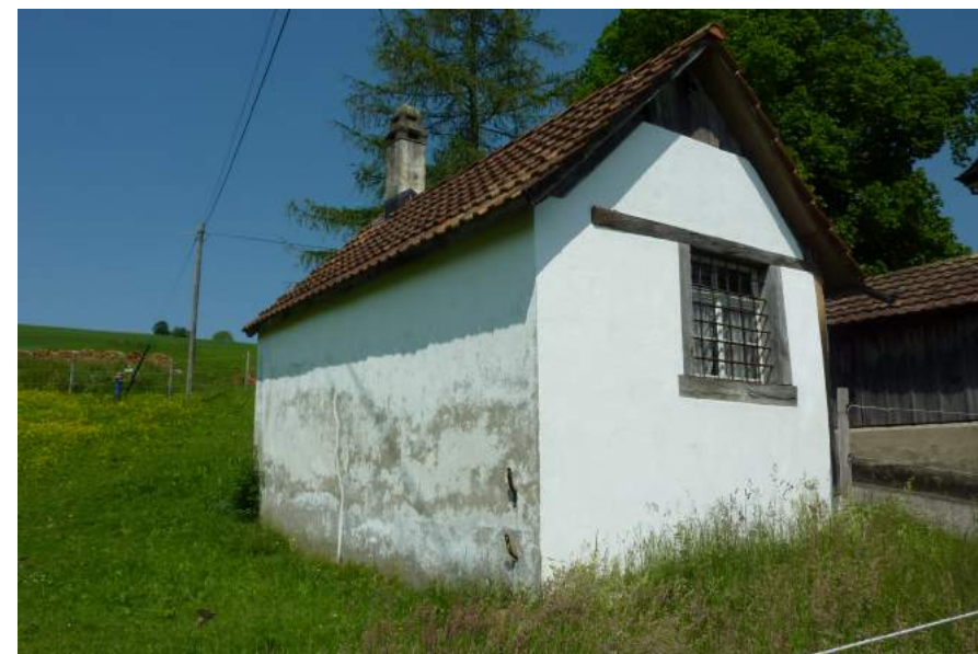
Gabeldingen, Waschhaus, Ansicht von SW
