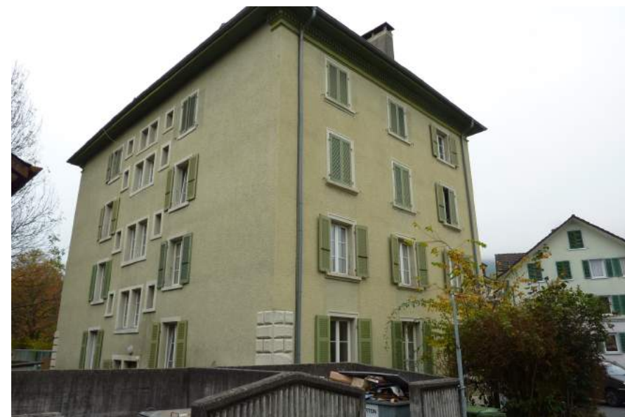
Horwerstrasse 1, Greterhaus, Ansicht von NO
