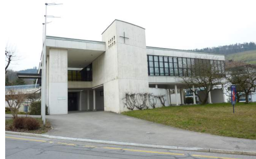
Hackenrainstrasse 2, Ansicht von SO
