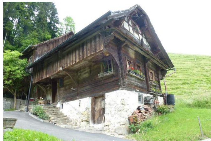
Schürhofstrasse, Houloch, Ansicht von S
