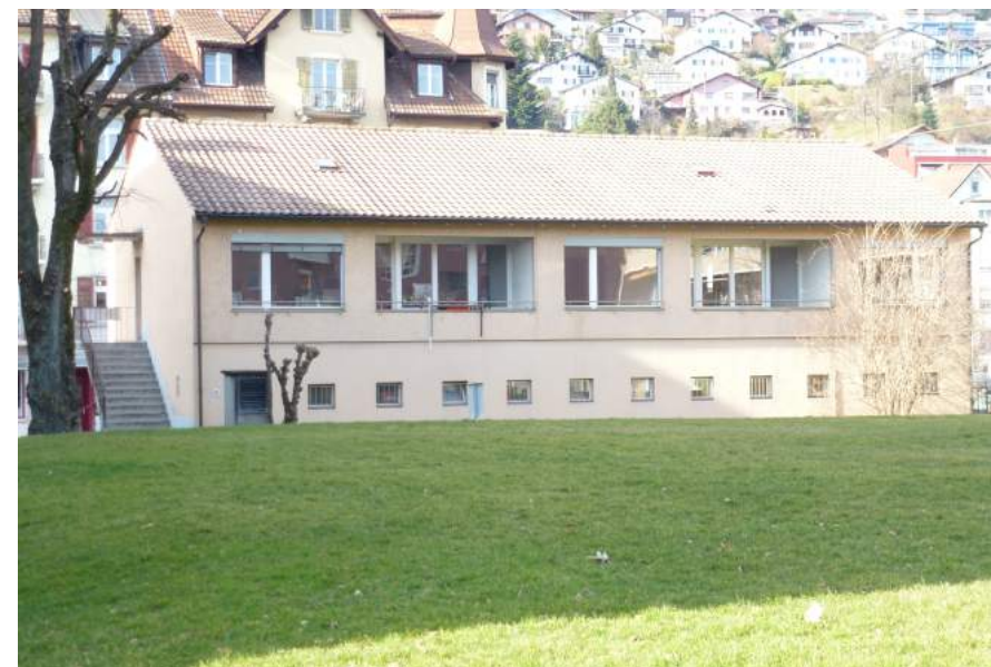
Luzernerstrasse 86, Ansicht von SO
