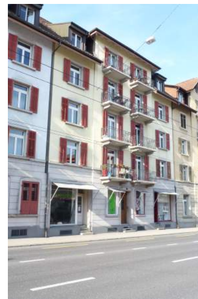
Luzernerstrasse 71, Ansicht von S
