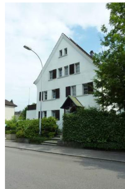
Hochrainstrasse 18, Ansicht von NW
