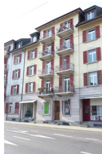
Luzernerstrasse 71, Ansicht von O
