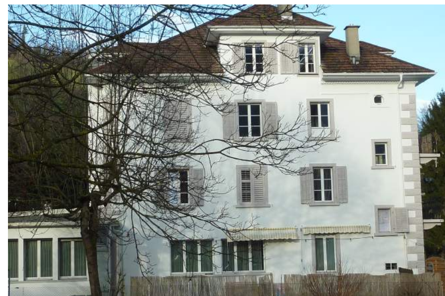
Obernauerstrasse 41, Restaurant Minerva, Ansicht von S
