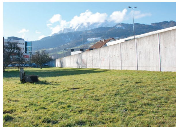
Freiraum zur Autobahn
