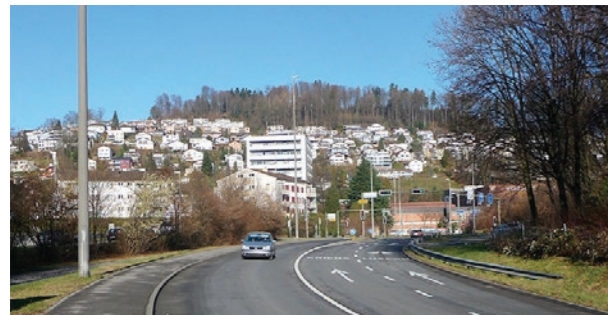
Eichwilstrasse Richtung Luzernerstrasse
