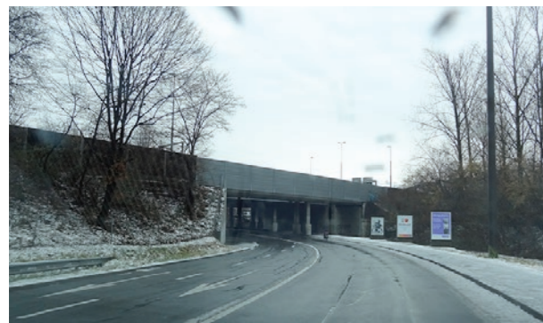
Eichwilstrasse Richtung Arsenalstrasse
