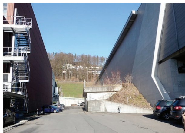
Rand A2 Portal Sonnenbergtunnel
