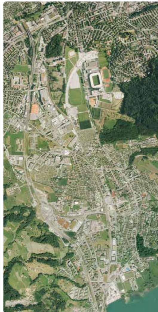
Luftbild Raum LuzernSüd: heutiger Zustand Quelle: map.geo.admin.ch
