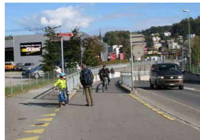
konfliktträchtige Unterführung Ringstrasse Horw: Fuss- und Veloverkehr auf engem Raum (Foto Team LuzernSüd)
