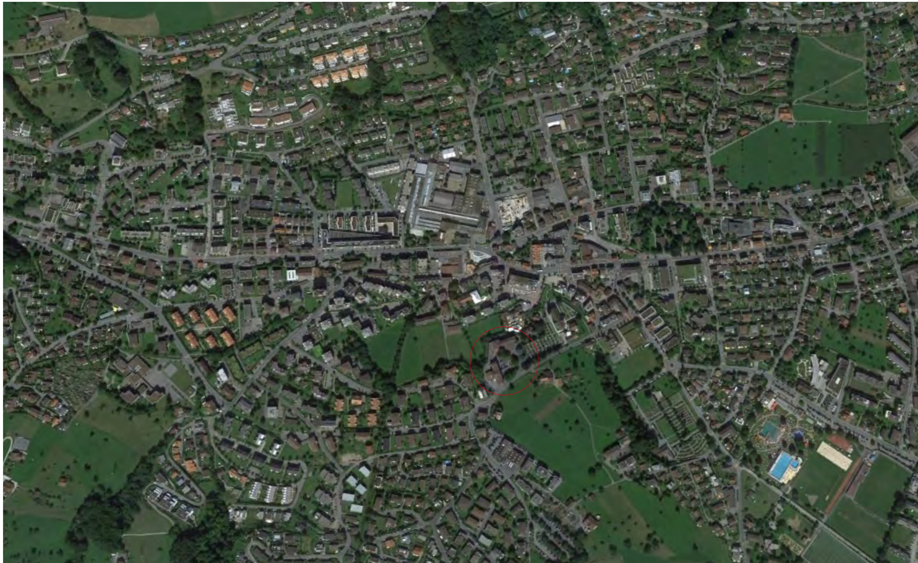
Luftbild Gesamtsanierung Schulanlage Kirchbühl 1+2, Kriens
