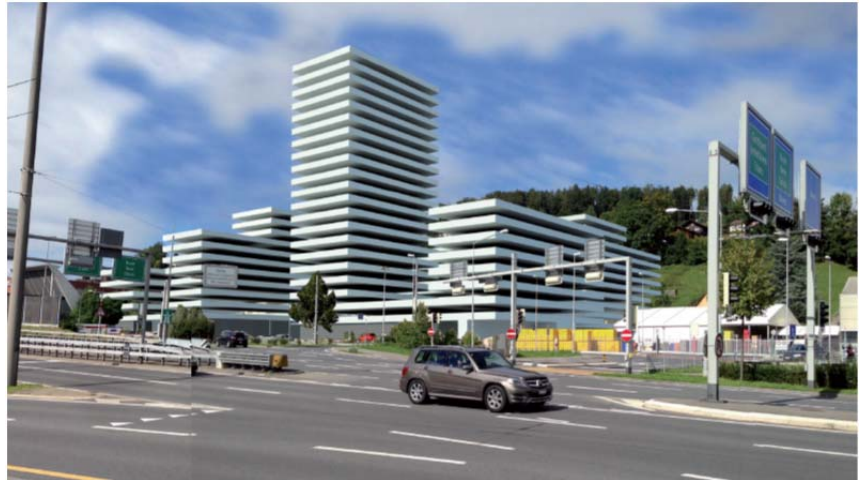
Abb. 1: Blick von der gegenüberliegenden Strassenseite auf das Gebiet Eichhof West (Visualisierung Stand Planung Oktober 2013)
