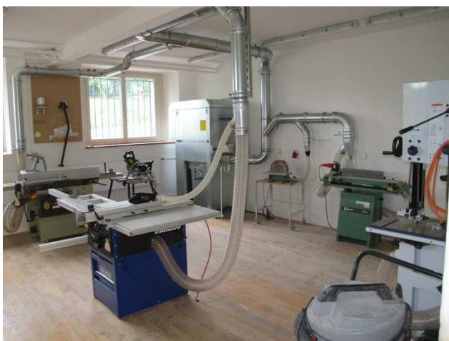
Sanierung Werkräume Schulhaus Kirchbühl 1
