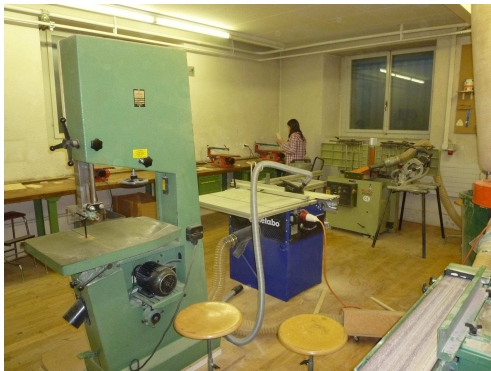
Sanierung Werkräume Schulhaus Kirchbühl 1
