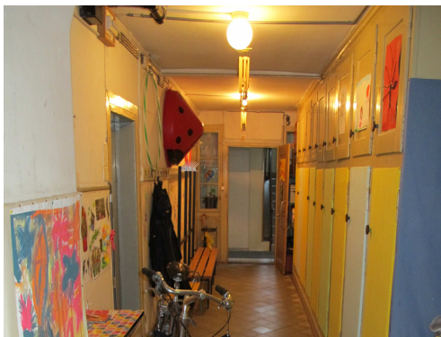
Sanierung Keller- und Erdgeschoss Haus Frühlicht
