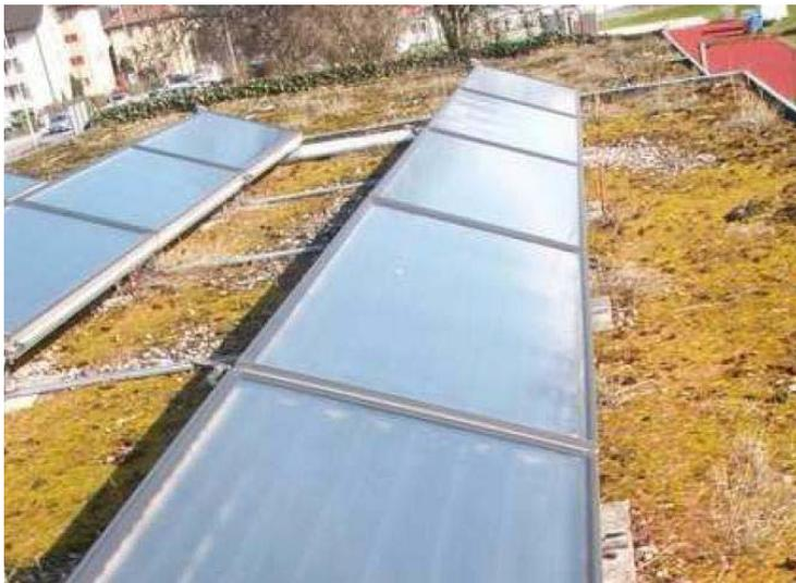
*Abbildung 12: Die bestehende Solaranlage auf dem Garderobengebäude wird nach der Sanierung für die Erzeugung von Brauchwarmwasser weiterverwendet.*
