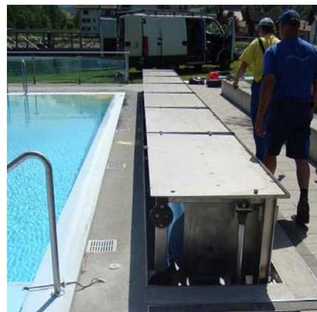
*Abbildung 9: Referenzbeispiel einer Beckenabdeckung während der Installation (links) und im Badebetrieb (rechts).*
