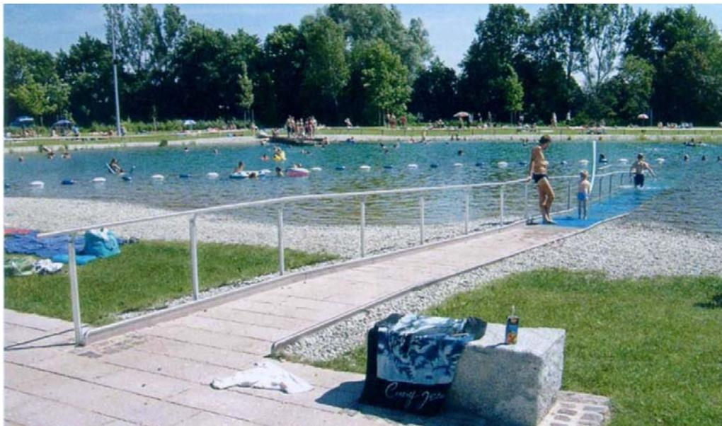
*Abbildung 23: Beispiel einer barrierefreien Rampenkonstruktion mit Handlauf.*
