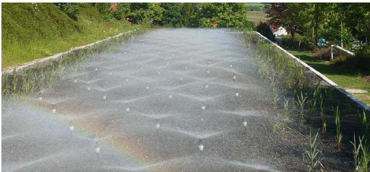
Abbildung 16: Referenzbeispiel des geplanten Trockenfilters im Betrieb.
