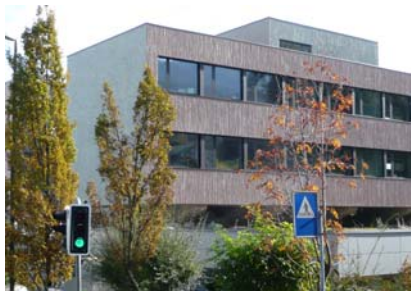
Schulanlage Krauer 2. + 3. Phase
