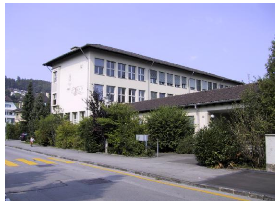
Südwestansicht von der Brunnmattstrasse
