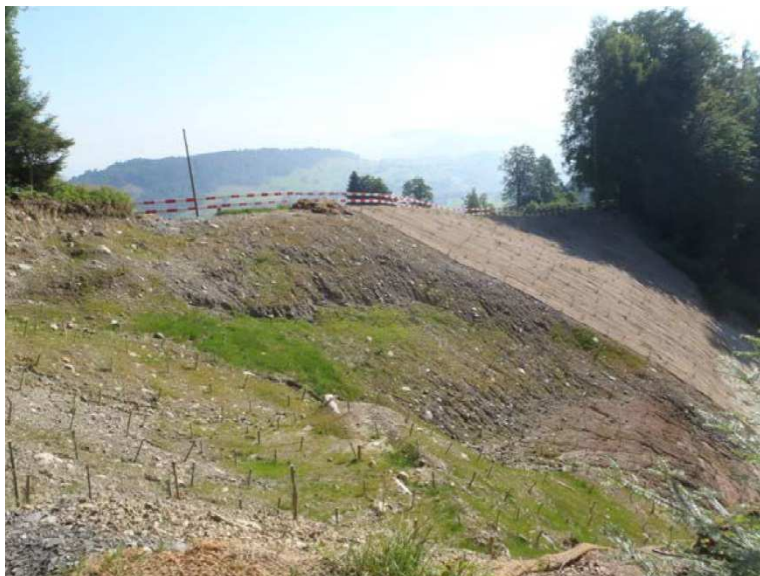
Ansicht der Rutschung im April 2015 nach Abtrag der Rutschmasse und Versetzen der Weidenstecklinge mit Ansaat
